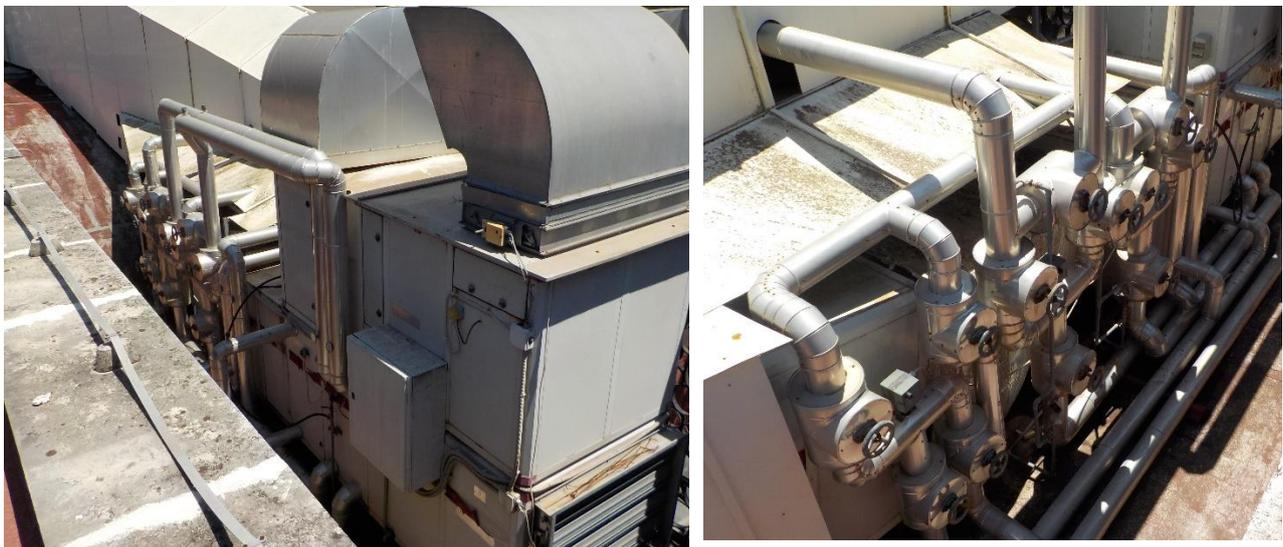
Figura 7.11 – Unità di trattamento aria e circuiti di regolazione.
