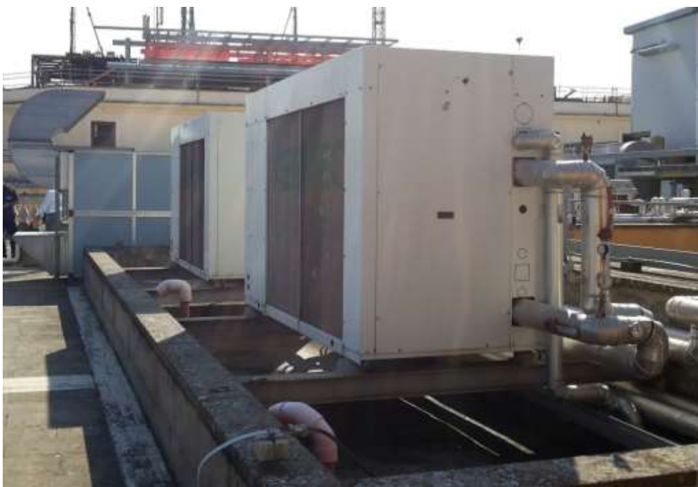
Figura 18: Pompe e le valvole di regolazione della centrale
