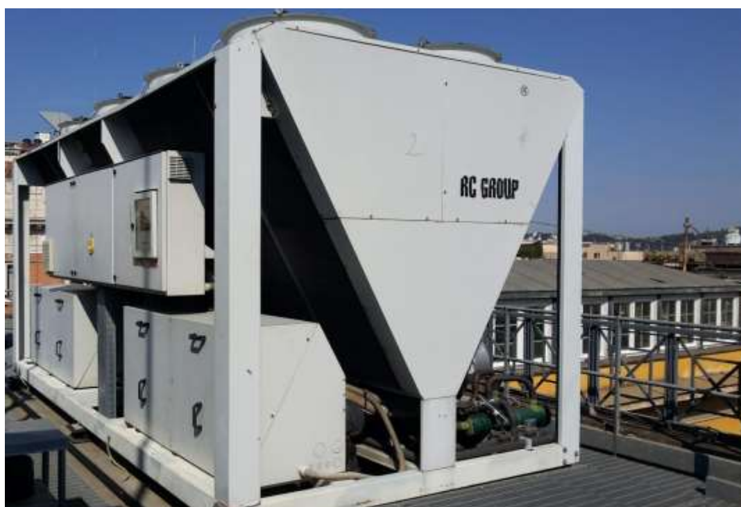
Figura 16: Pompe di calore
