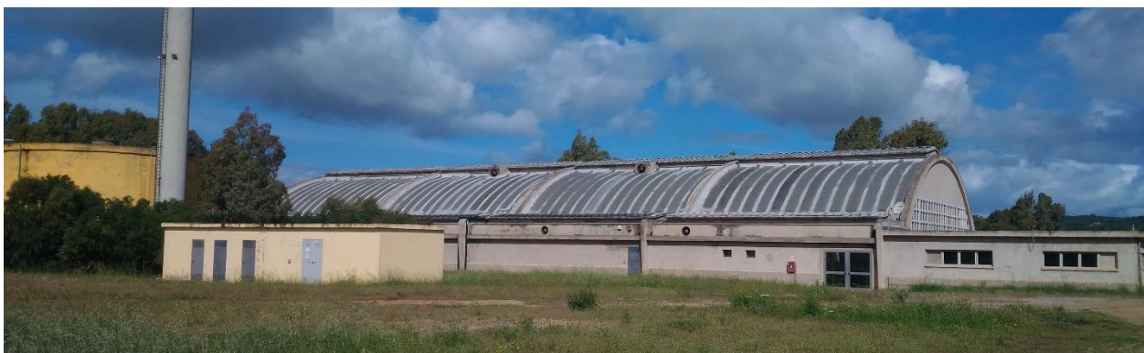
Figura 13. Vista sul complesso del Museo del Carbone, prospetto sud-est
