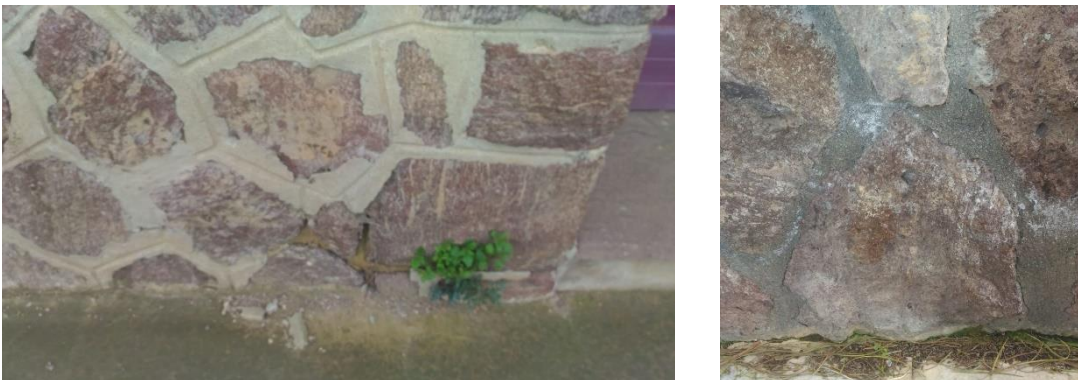
Figura 52. Segno esterno espulsione salina e distacchi Museo PAS
