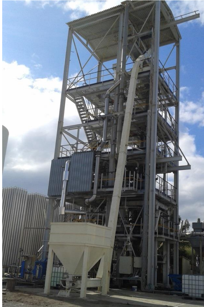
Figura 2.3. Sistema di caricamento automatico del combustibile (redler).
