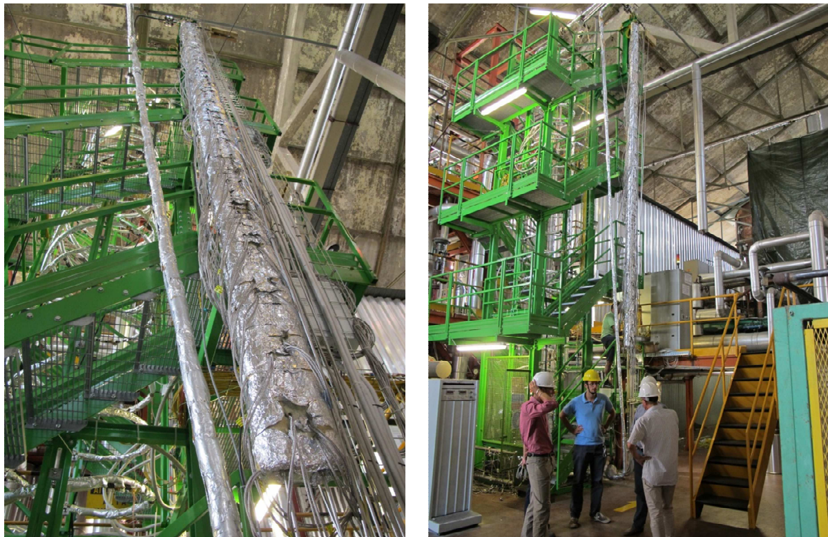
Figura 8 – Immagini della sezione di prova HERO-2 installata.
