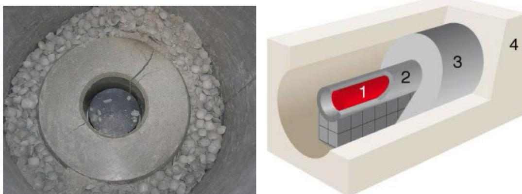
**Figura 7 Sistema iniziale di riempimento con bentonite (omogeneo) – SKB Patrick Sellin**
