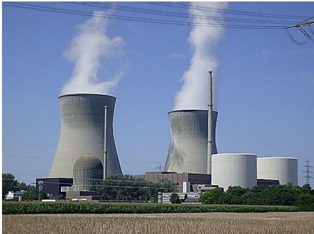
Figura 5 – Vista della centrale nucleare di Gundremmingen 8 .
