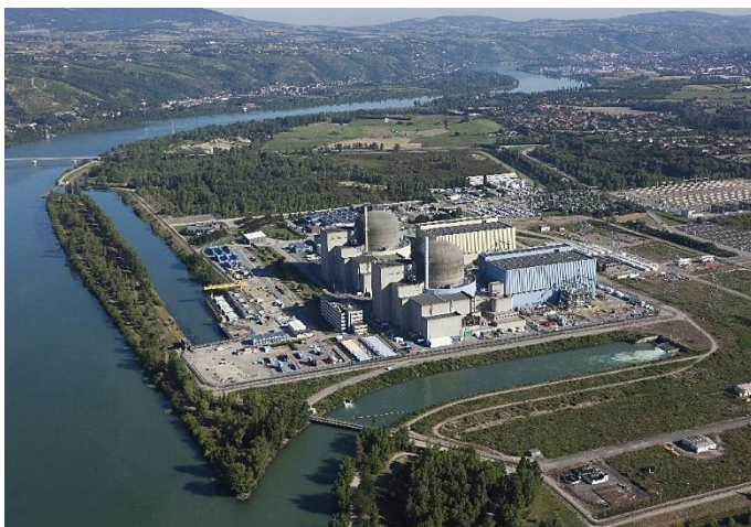
Figura 18 – Vista della centrale di Saint Alban 19 .
