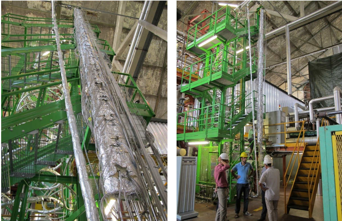
Figura 7 – Immagini della sezione di prova HERO-2 installata.
