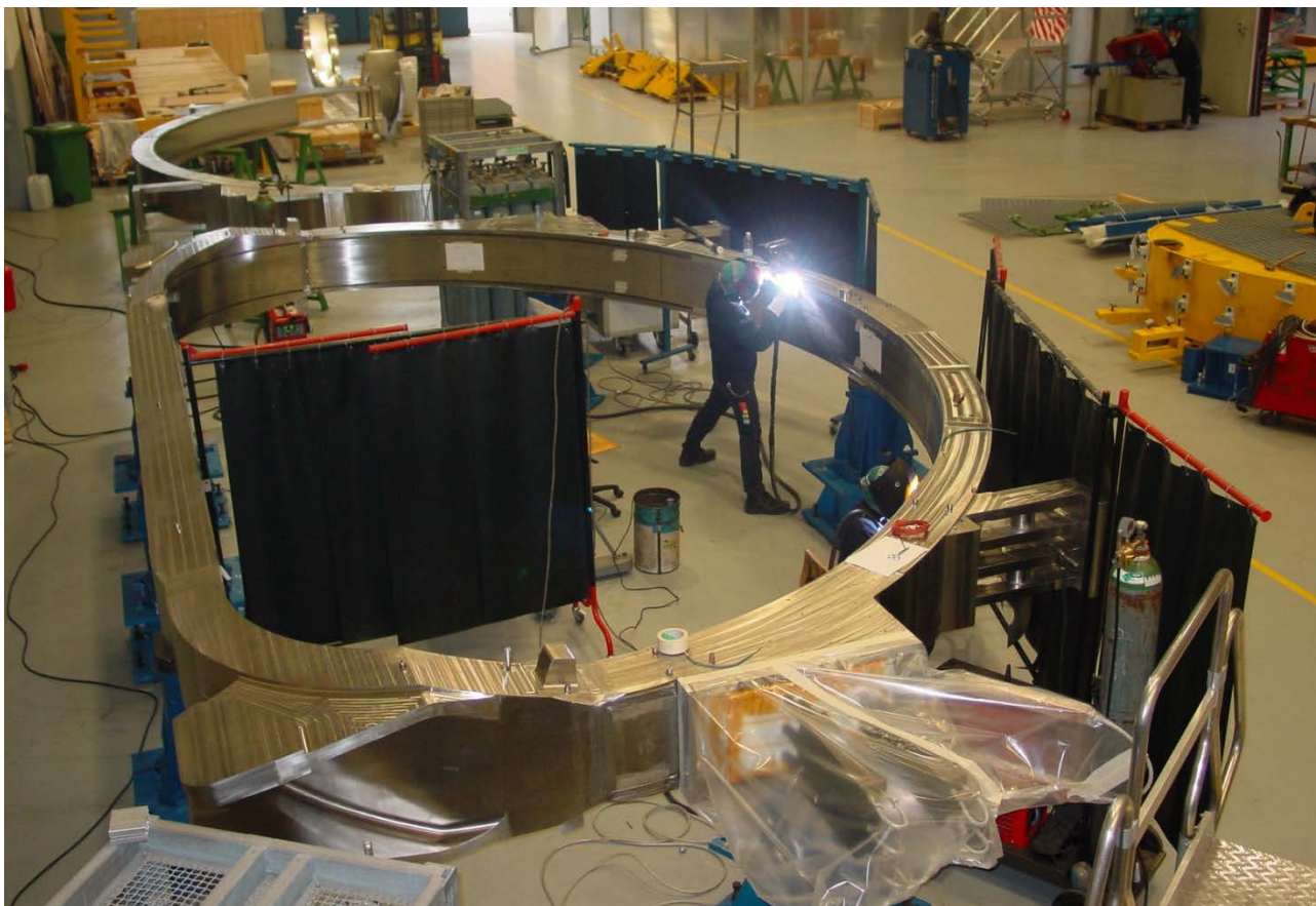
Figura 6 Saldatura di riempimento del cianfrino del coperchio della TFC-02
