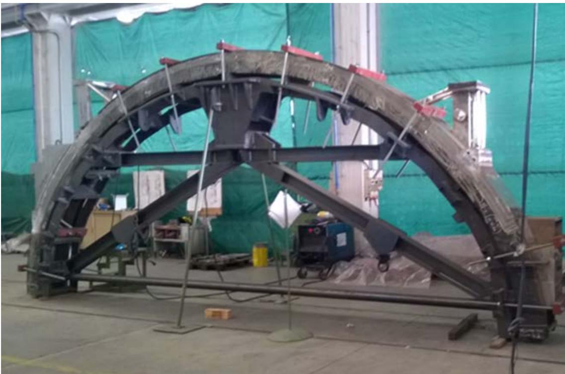
Figura 4: Saldatura dei supporti esterni alla gamba curva.
