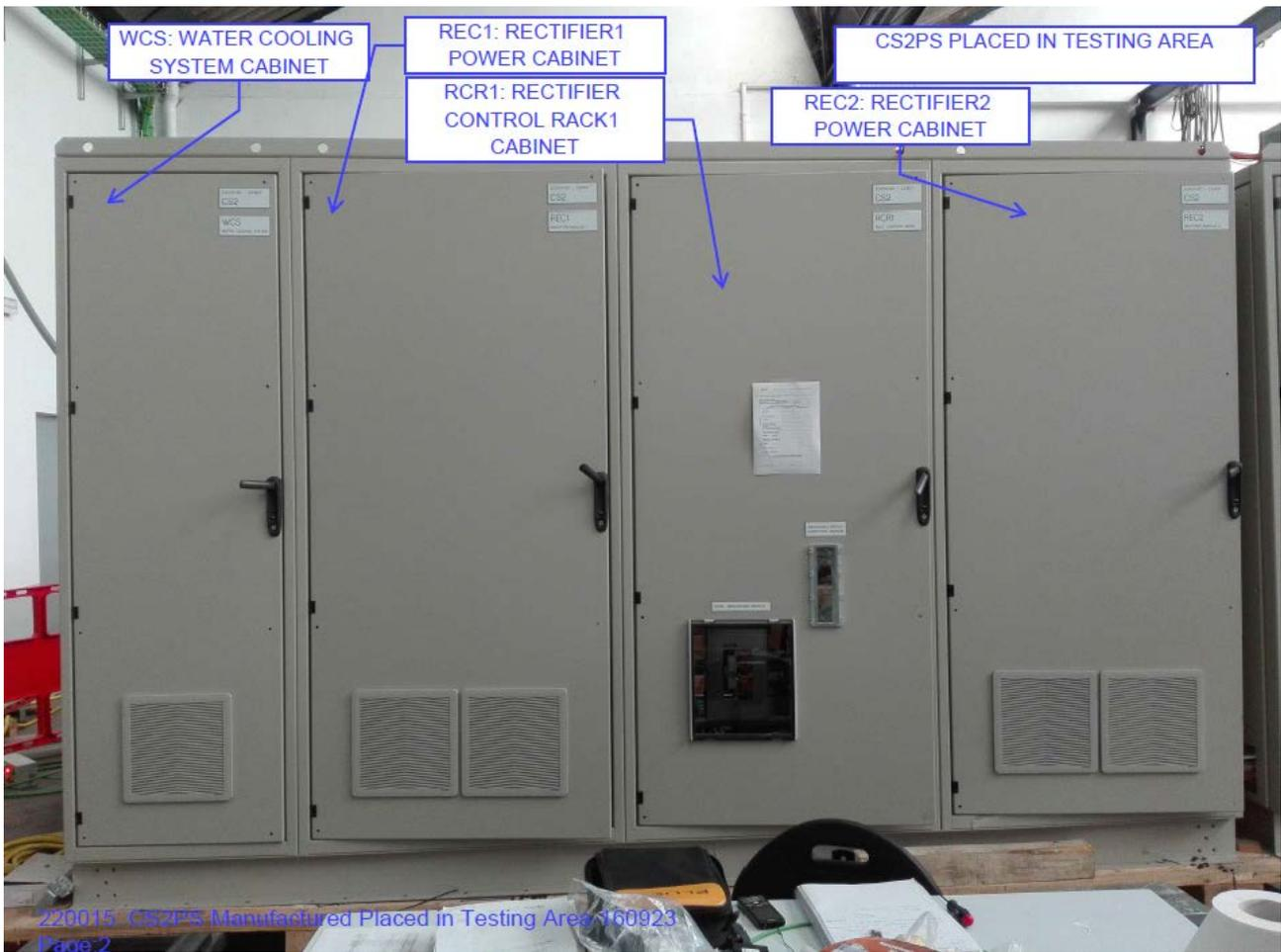
Figura 22 – dettaglio CS2
