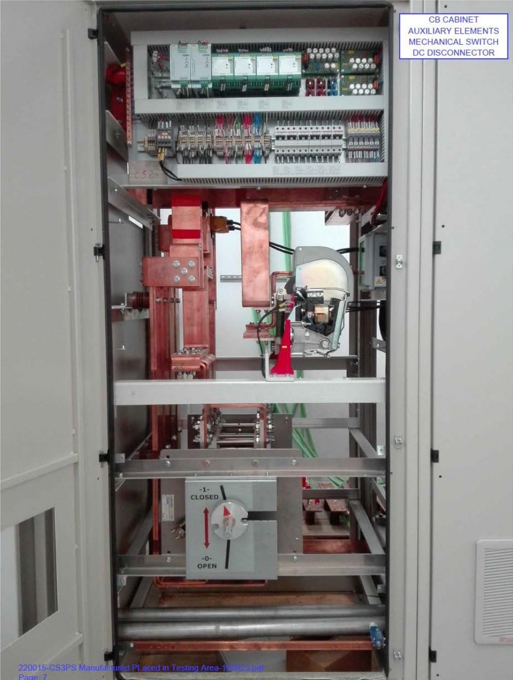
Figura 19 – dettaglio del sezionatore DC.
