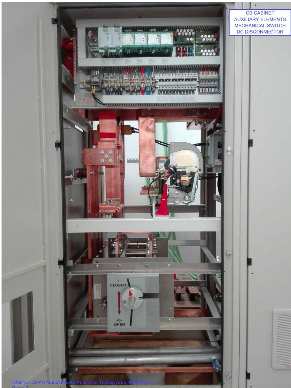
Figura 2 – dettaglio del sezionatore DC.
