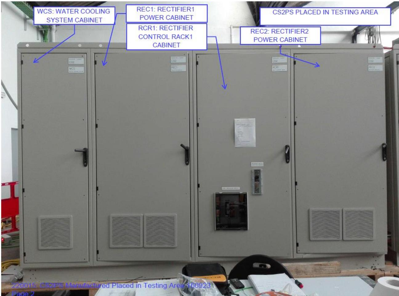
Figura 5 – dettaglio CS2
