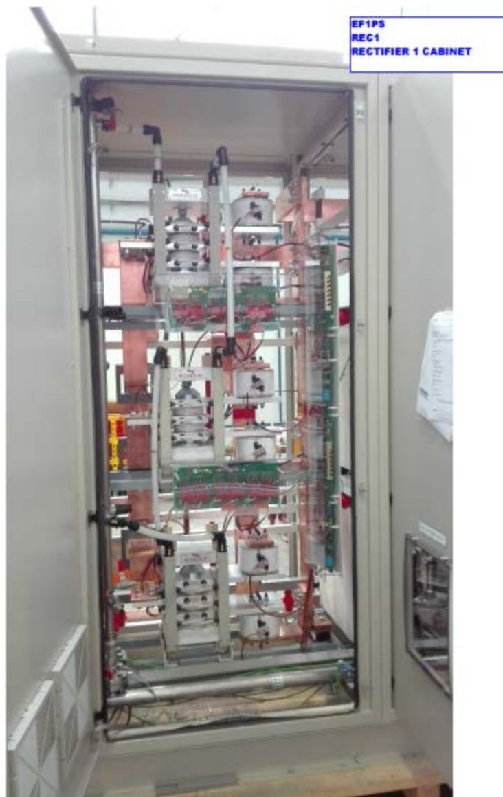
Figura 13 – Armadio 4 con tiristori EF1
