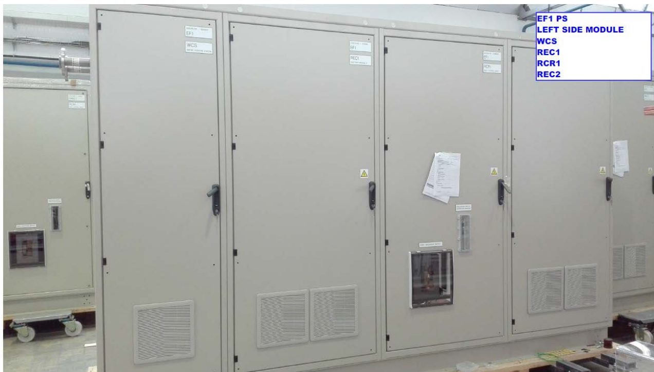
Figura 11 – Armadio con tiristori EF1.
