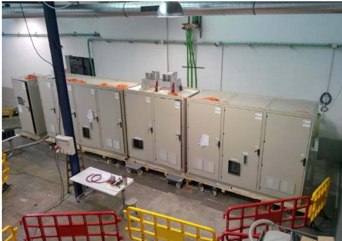
Figura 10 – EF6 posizionato nella sala prove.
