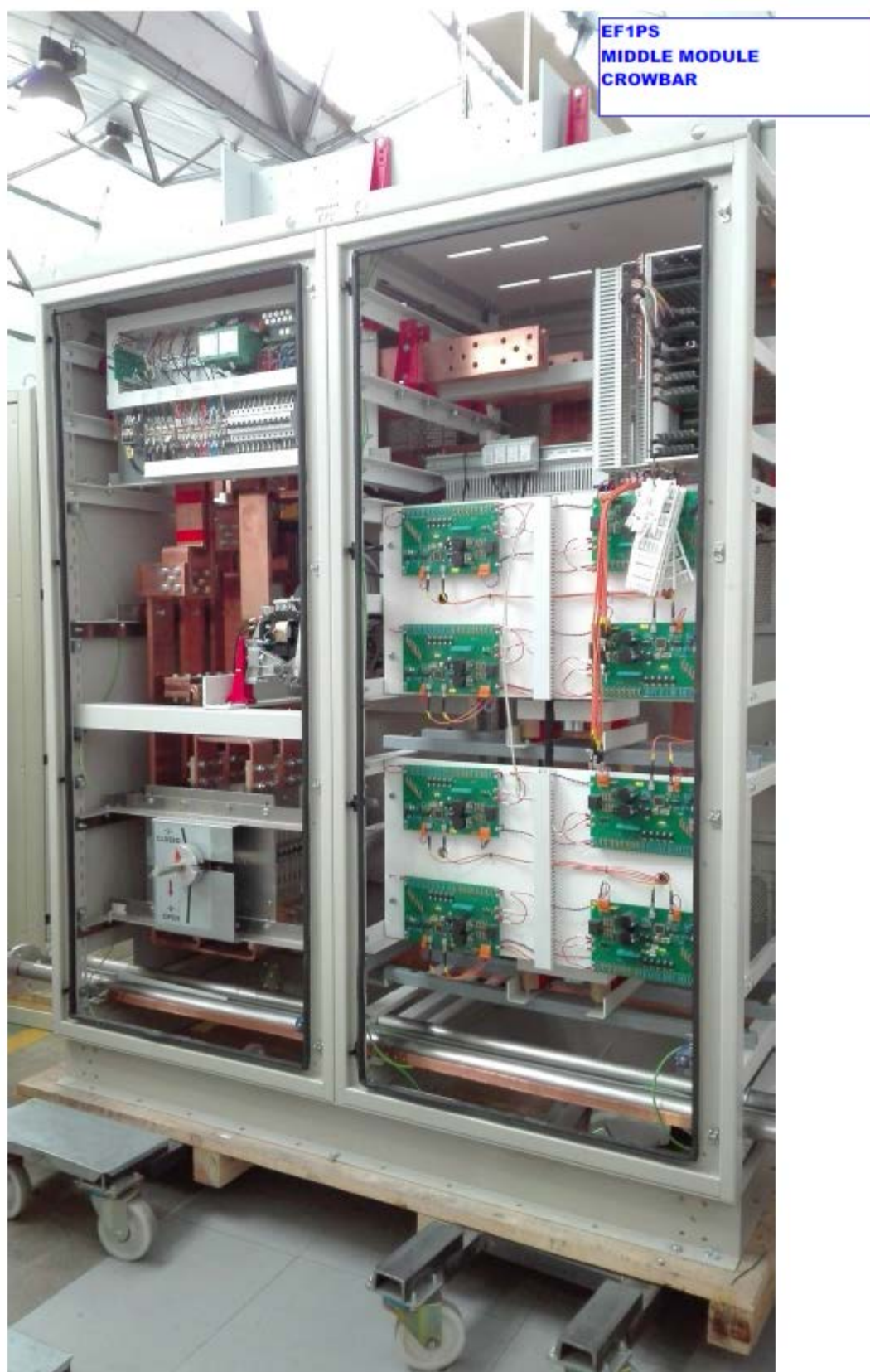
Figura 16 – dettaglio EF1 sezionatore DC e crowbar
