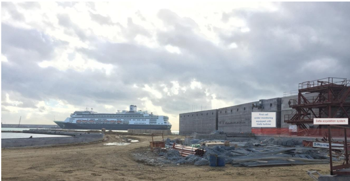
Figura 32. Sistema di acquisizione operativo a Civitavecchia: due celle attive monitorate mediante sensori di misura su due celle adiacenti, una con turbina e una con sfiato, e collegate ad una stazione di acquisizione dati.
