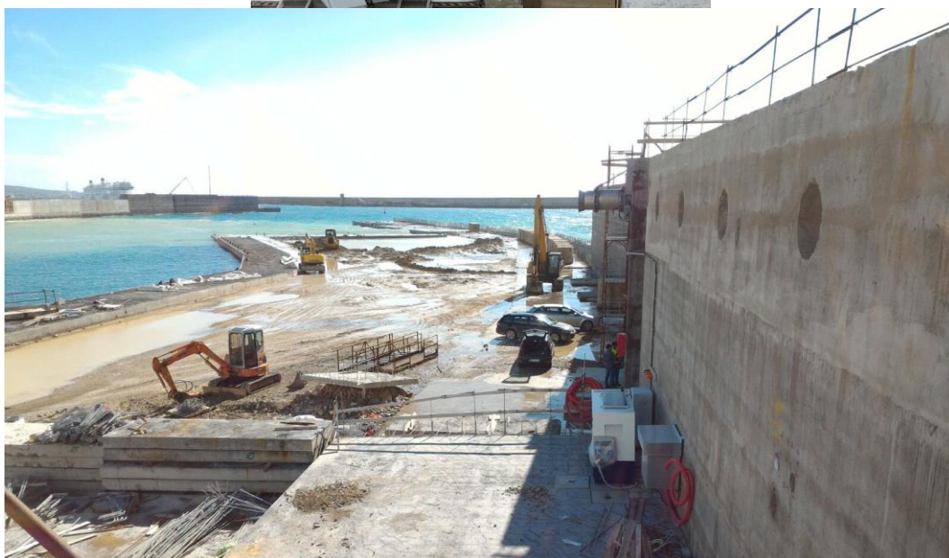
Figura 29. Fasi di installazione della turbina di Wells.
