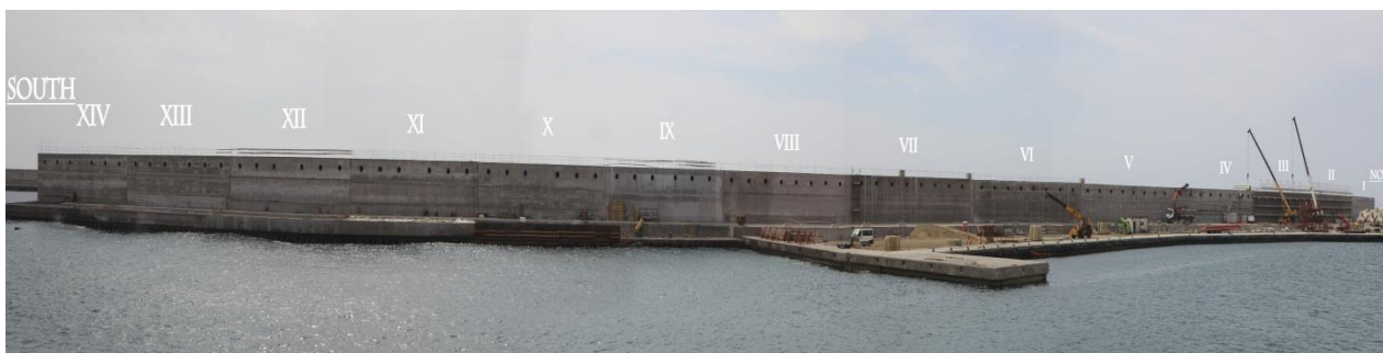
Figura 14. – Alcune immagini dell'avanzamento dei lavori di costruzione dei cassoni REWEC3 nel Porto di Civitavecchia. Pannello superiore: Maggio 2014; pannello centrale: Marzo 2015; pannello inferiore: Settembre 2016.
