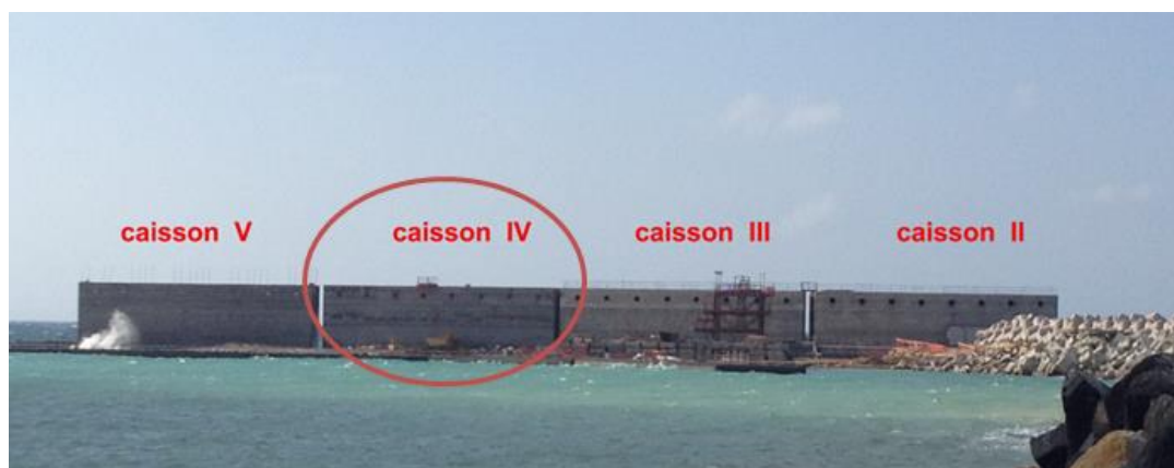
Figura 28. Vista del cassone in cui due celle adiacenti sono attualmente strumentate per il monitoraggio. Nella cella più a Nord confinate con il cassone III è posizionata la turbina, in quella adiacente è operativa la strumentazione con sfiato da 0.45m.
