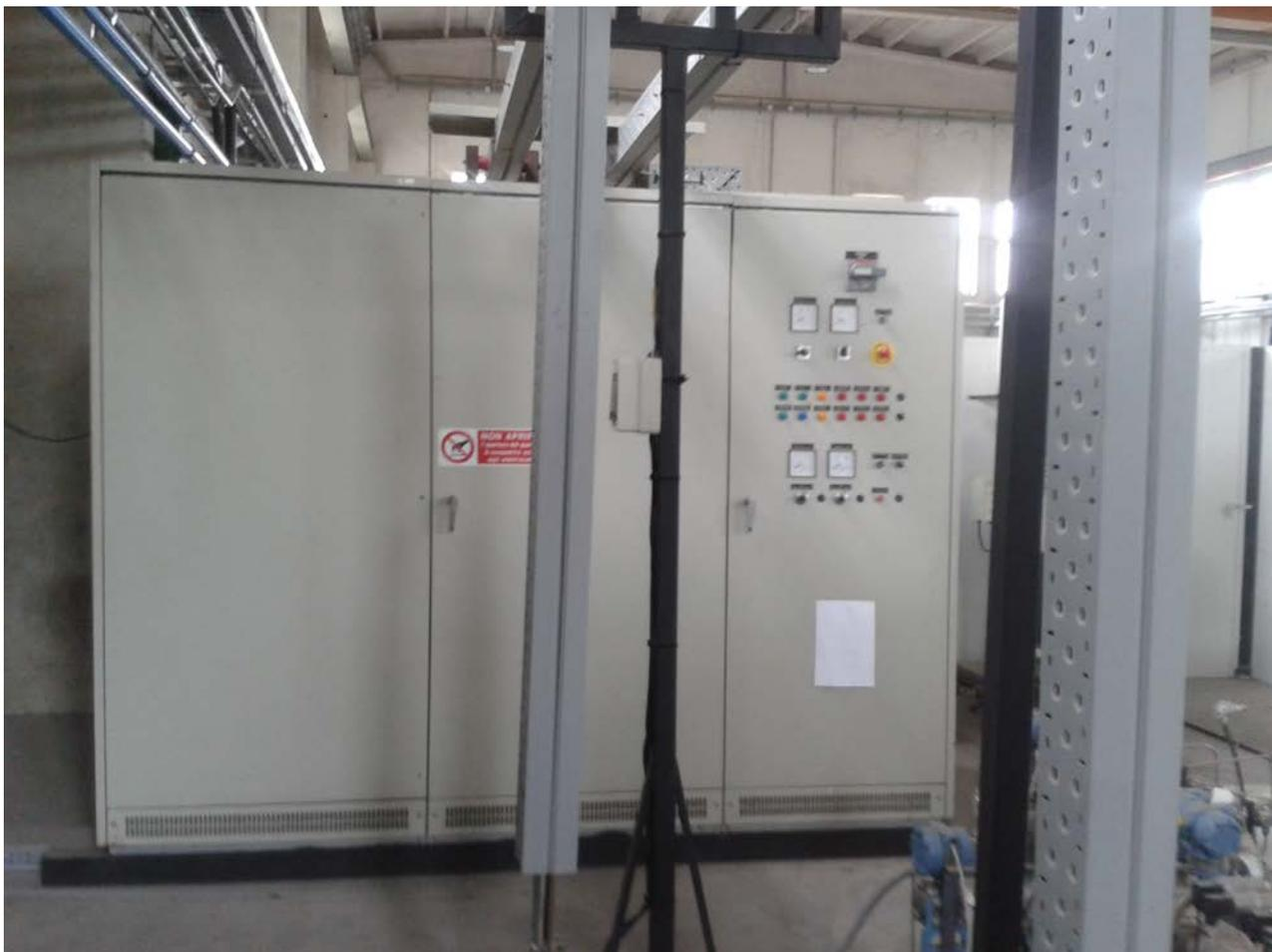
**Figura 8 –Alimentatore elettrico in cc e barre di alimentazione caldaia elettrica**
