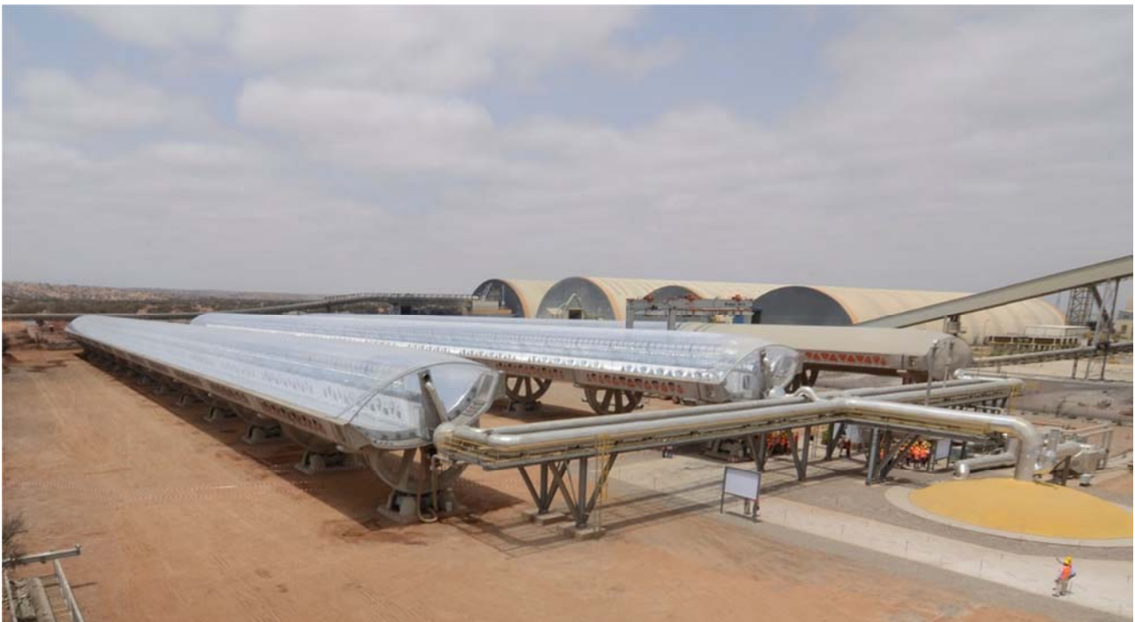
Figura 10. Concentratori parabolici lineari con copertura pneumatica nella centrale Airlight Energy di Ait-Baha (Marocco).
