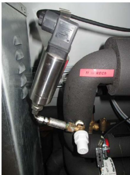
Figura 4. Sensore di pressione GE DRUCK serie PTX 600
