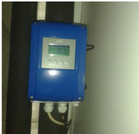
Figura 5. Misuratore di portata Krohne optiflux 5000
