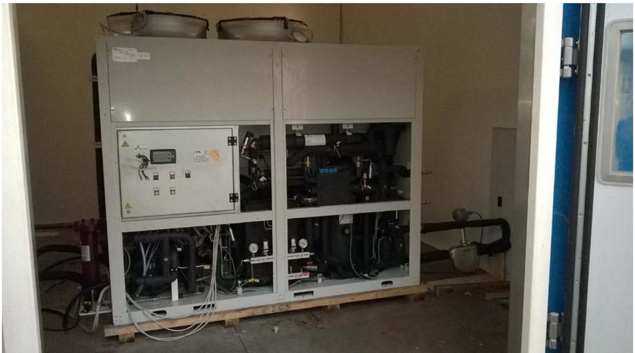
Figura 11. La PdC in test in camera climatica con misuratore di portata sul secondario (a destra)
