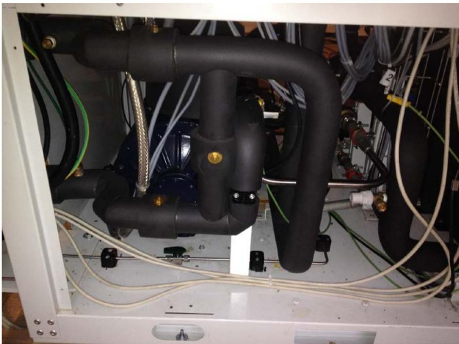
**Figura 27. Sezione di by-pass del separatore d’olio**
