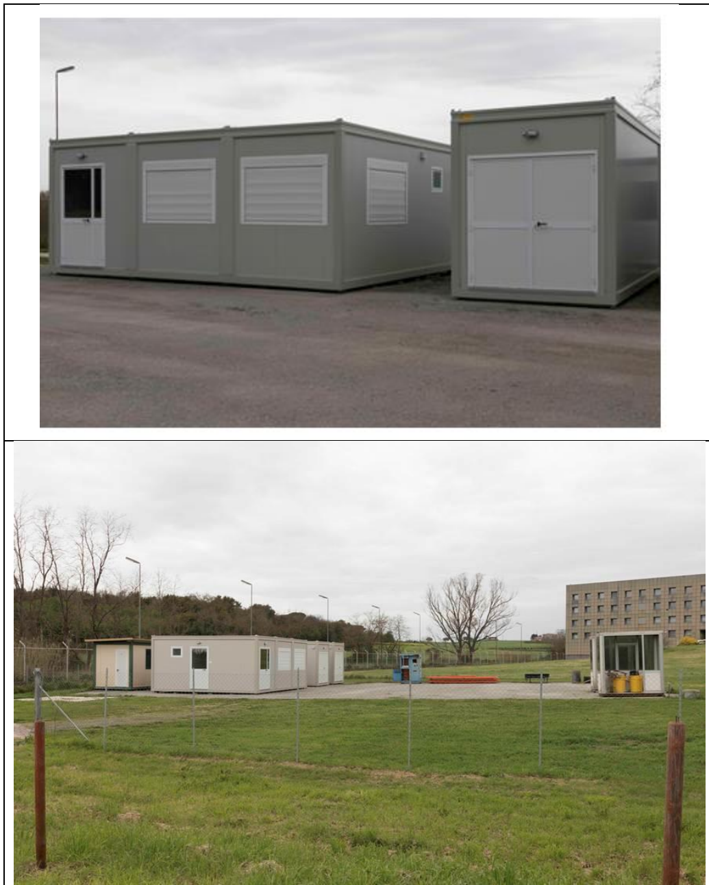
Figura 7. PAR 2017 – EV: acquisto e posizionamento di nuovi moduli, tra cui una unità per prove da fumo
