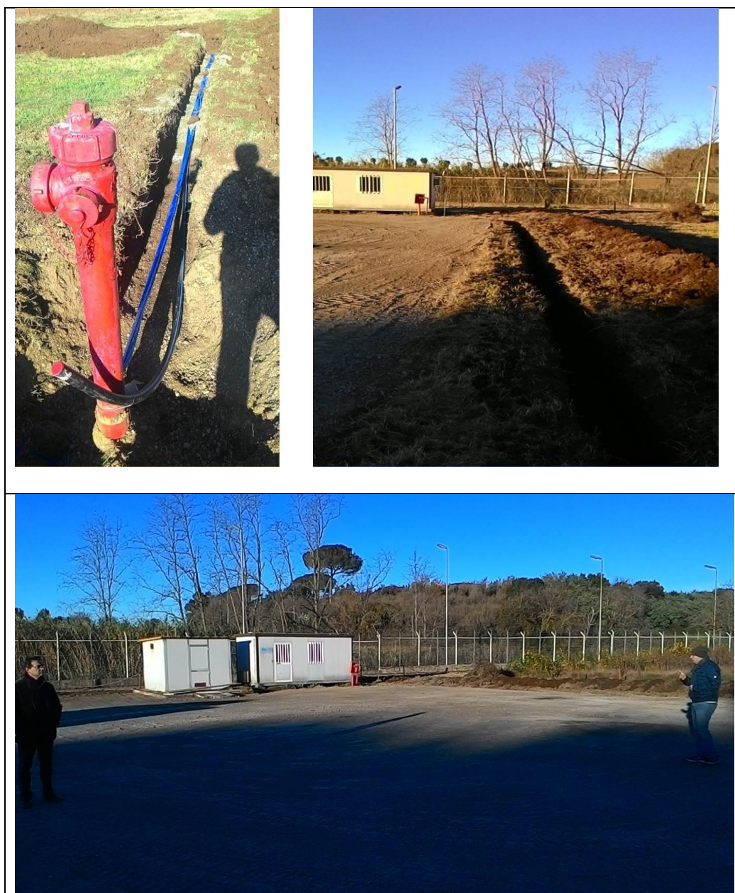
Figura 6. Primi lavori eseguiti nel corso del PAR 2015 (opere di pulizia, scavo e installazione box di recupero) e del PAR 2016 (perimetrazione e cancello)
