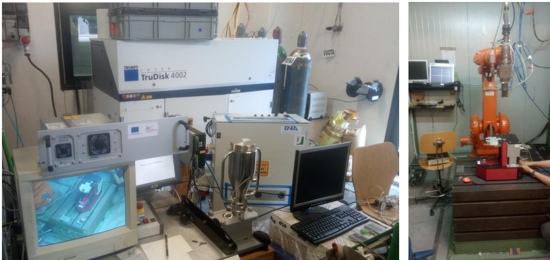
Figura 34: Armadi elettrici del laser TRUDISK
