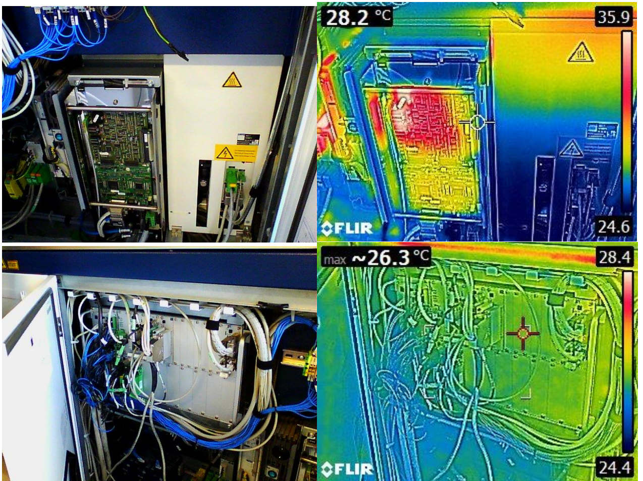
Figura 38: Monitoraggio degli armadi elettrici di potenza del laser TRUMPF dopo l'emissione
