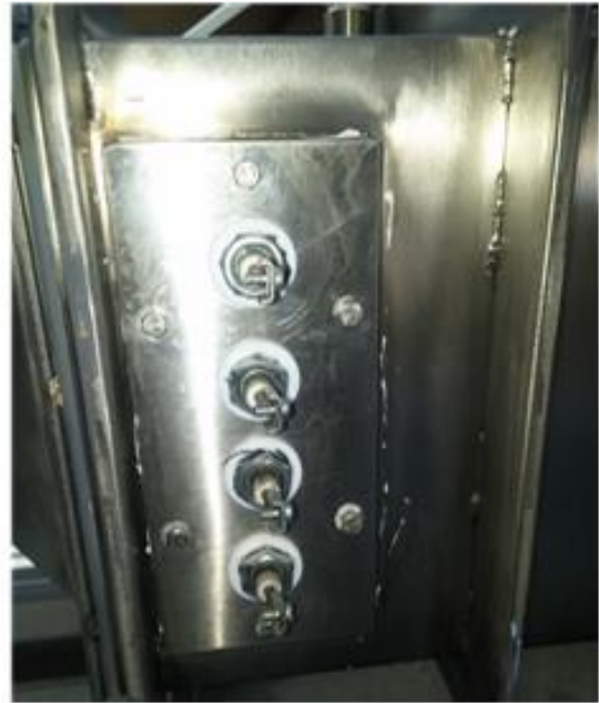
Figura 3.6 Riscaldatori elettrici montati su flangia di inserzione trasversale nel plenum
