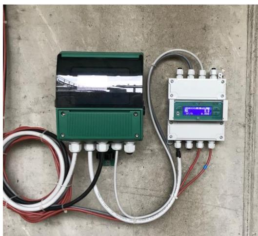
Figura 5 Assorbimento elettrico alla caldaia
