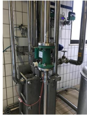
**Figura 9: Misuratori di energia termica dei reparti di produzione**
