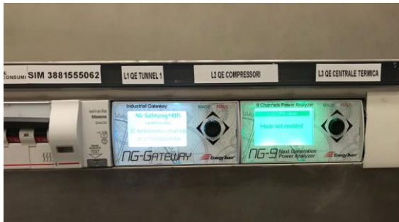
Figura 10: Gateway e misuratori assorbimento elettrico chillers
