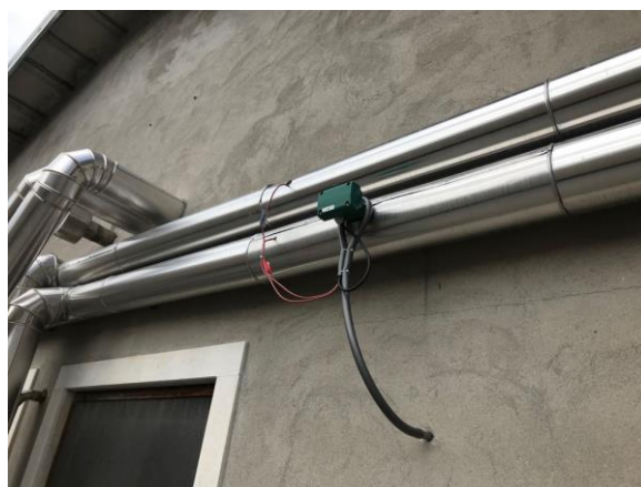
Figura 7: Misuratore energia termica – Linea Vapore al processo
