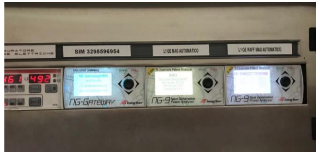
Figura 10: Gateway e misuratori assorbimento elettrico chillers
