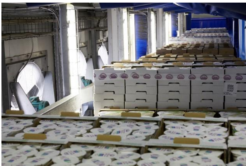
Figura 22 Tunnel per il free-cooling
