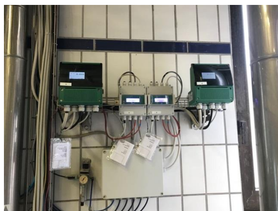
Figura 7: Misuratore energia termica – Linea Vapore al processo
