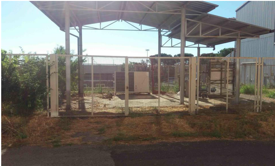
Figura 2.15 - Tettoia esterna dove sarà installato l'impianto sperimentale CO 2 ATTO
