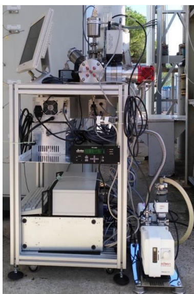
Figura 2 - Strumento per l'analisi dei gas post-combustione DOES installato presso l'impianto ZECOMIX.
