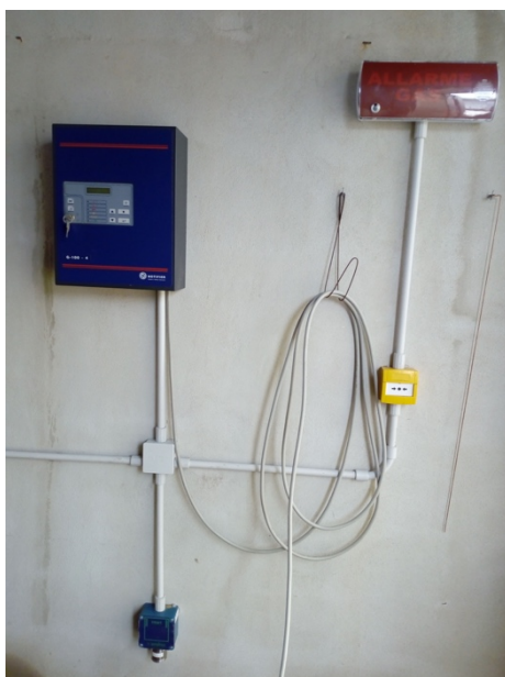
Figura 3.7. Componenti del sistema di rilevazione H 2 S.
