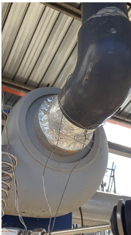
Figura 3.2. Sigillo canale di aspirazione.
