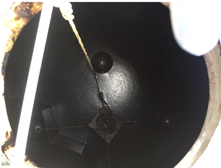
Figura 16. Scolmatore installato nel Tank Scrubber
