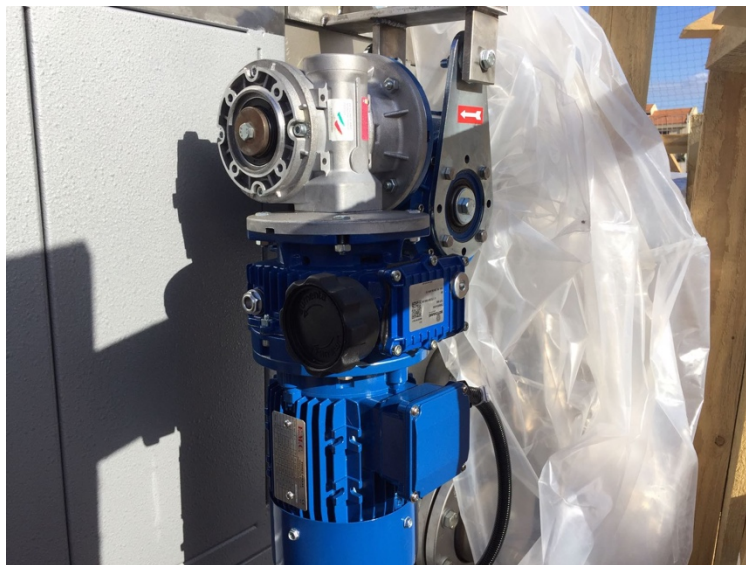
Figura 18. Vasca di scrematura con pompa di rilancio
