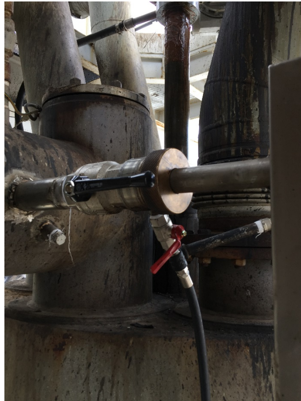
Figura 10. Sonda di campionamento riscaldata
