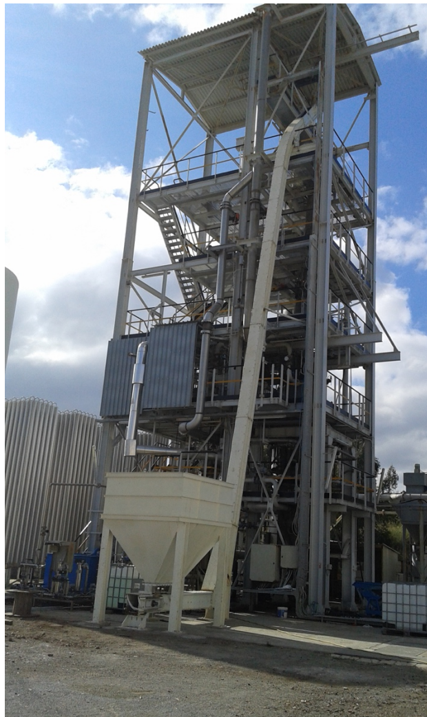
Figura 1. Sistema di caricamento automatico del combustibile "Redler"
