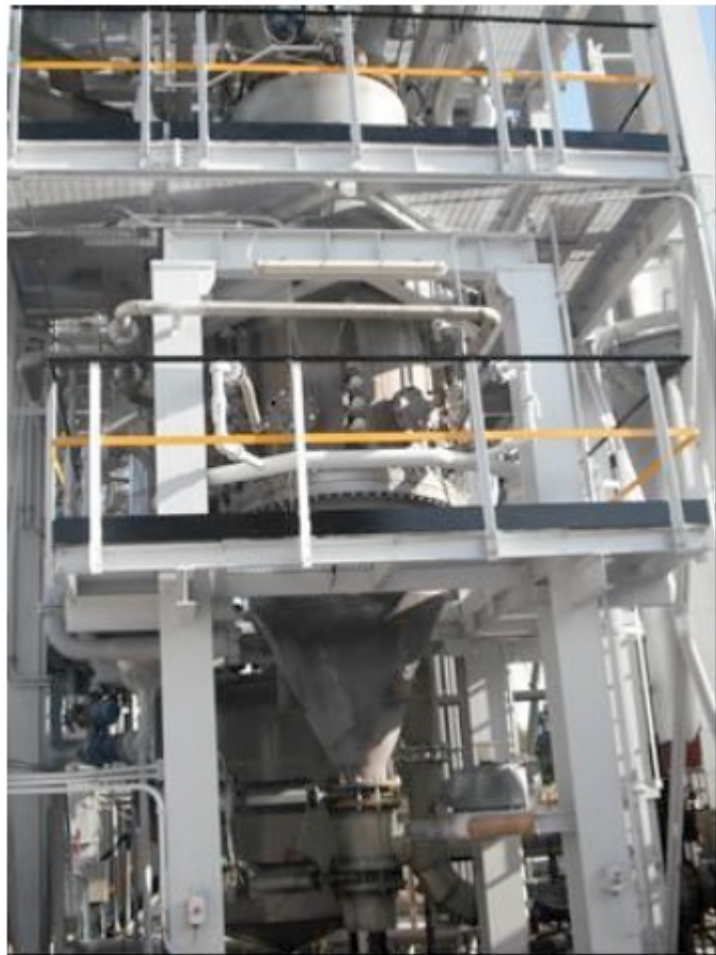
Figura 2. Gassificatore impianto dimostrativo
