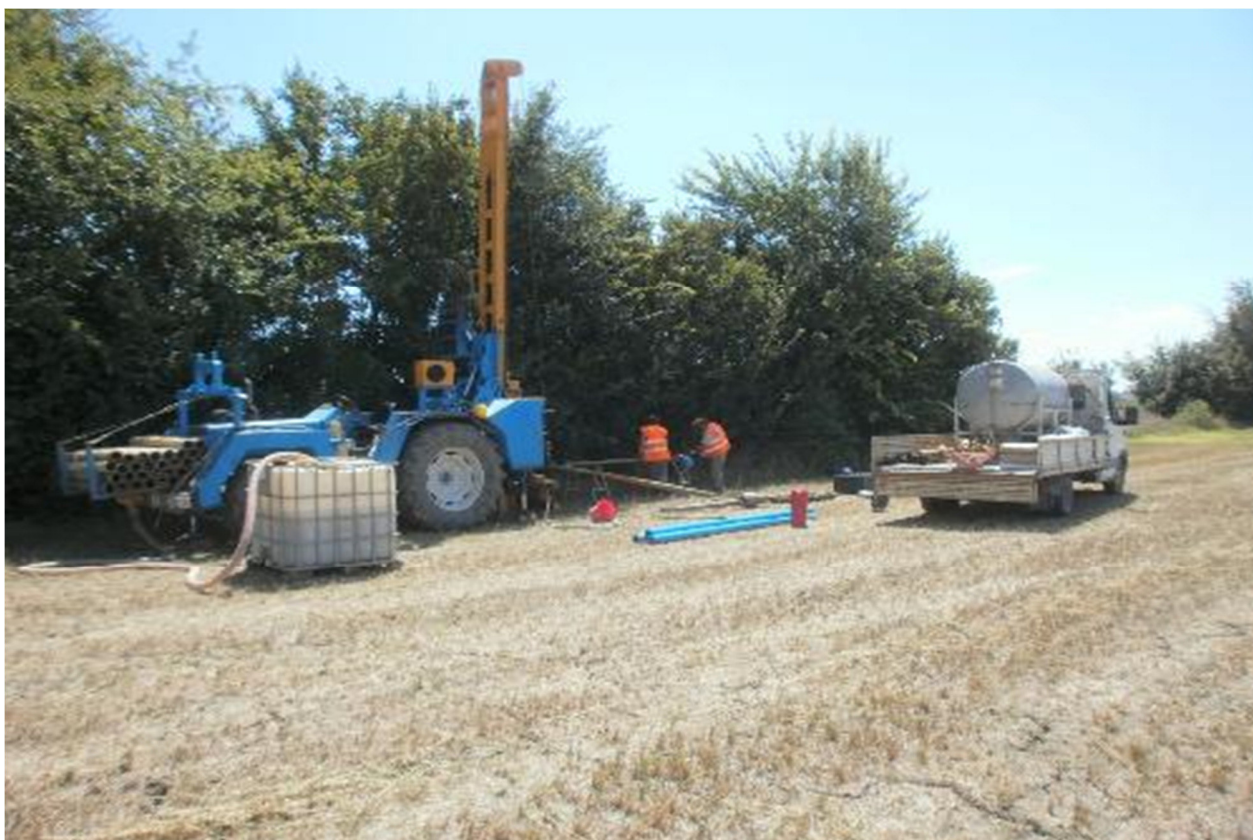
Figura 14: Ingombro tipo dell'area di cantiere delle perforazioni
