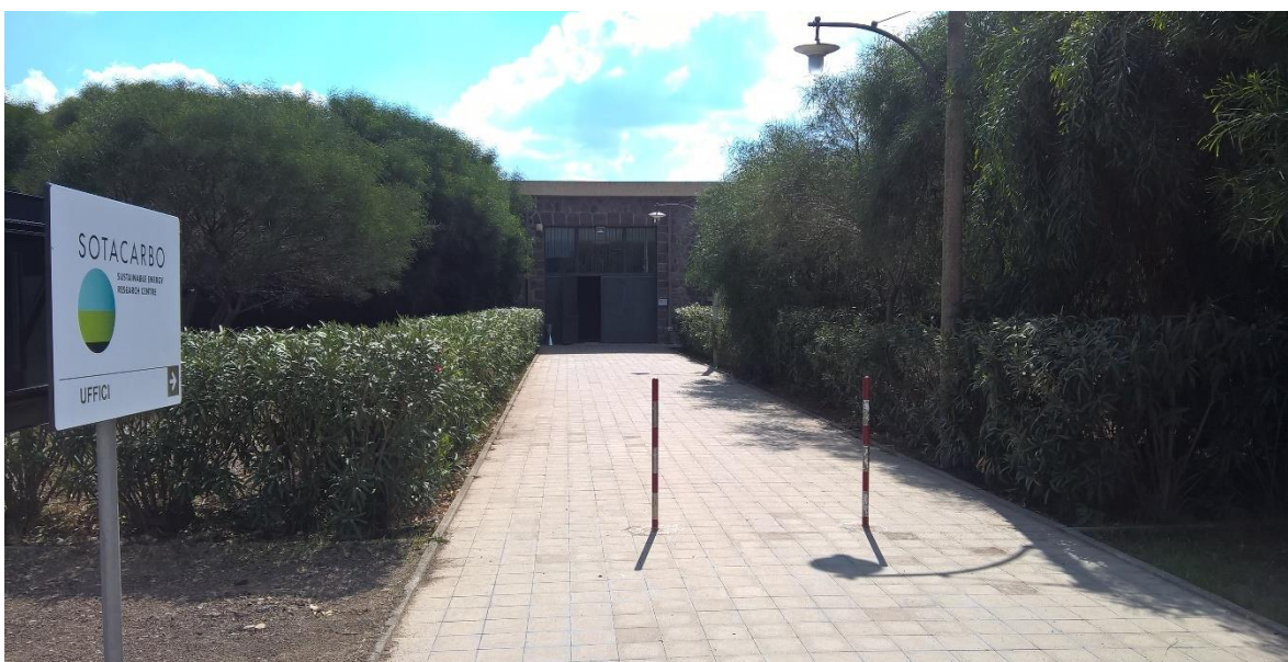
Figura 2.2.1. Centro ricerche Sotacarbo (prospetto anteriore).
