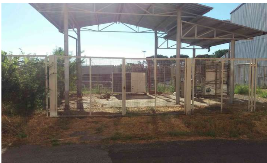
Figura 2.16 - Tettoia esterna dove sarà installato l'impianto sperimentale CO 2 ATTO
