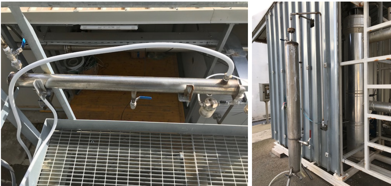
Figura 101. Scambiatore di calore a doppio tubo e polmone di separazione liquido.
