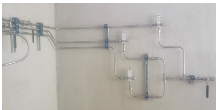
Figura 2.4. Circuito di alimentazione gas: flussimetri e valvole di sezione.
