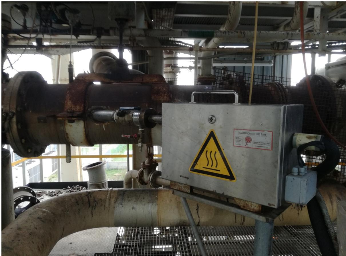
**Figura 11. Nuova installazione del sistema di campionamento TAR (Gamba&Botteghi)**
