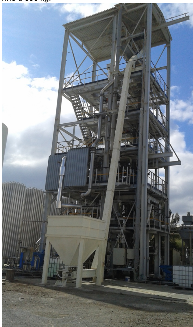
Figura 2. Sistema di caricamento automatico del combustibile "Redler"
