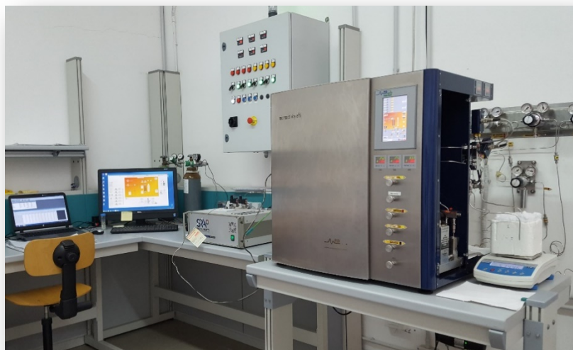
Figura 2.1. Impianto XtL installato presso il laboratorio Sotacarbo "Carbon to new fuels".
