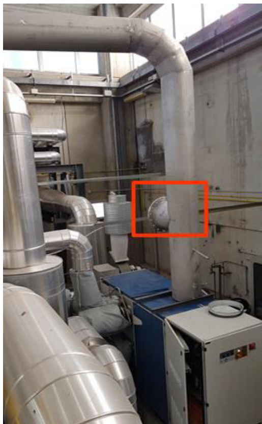
Figura 10. Sezione di collegamento tra il loop EGR e l'aspirazione della turbina a gas.
