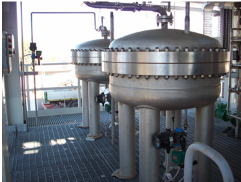
Figura 8. Reattori di assorbimento dell'anidride carbonica.
