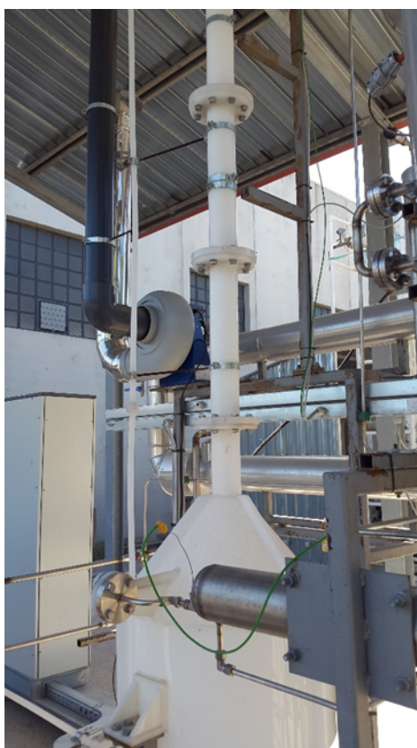
Figura 8 Colonna di assorbimento -C201
