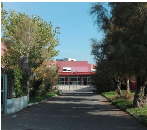
Figura 17. Istituto tecnico Carlo Urbani (sopralluogo Ostia)
