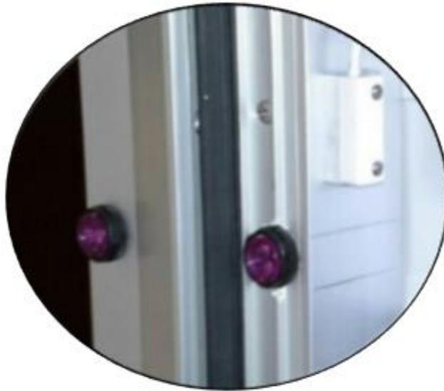
**Figura 77 - Sensori di prossimità che configurano il sistema di conteggio degli accessi al locale monitorato. E' anche mostrato il sensore magnetico che individua l'apertura e la chiusura della porta.**
