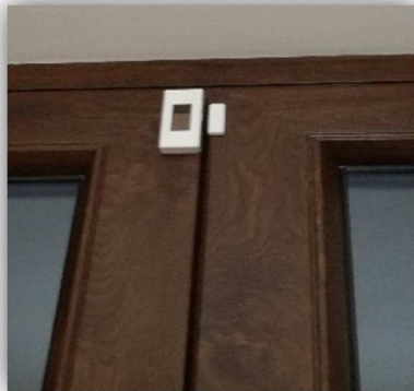
Figura 17- Sensore FTKB- rw installato su una finestra
