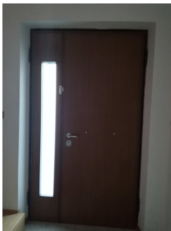
Figura 18- Sensore Slim multisensor installato sulla porta d'ingresso dell'abitazione 8
