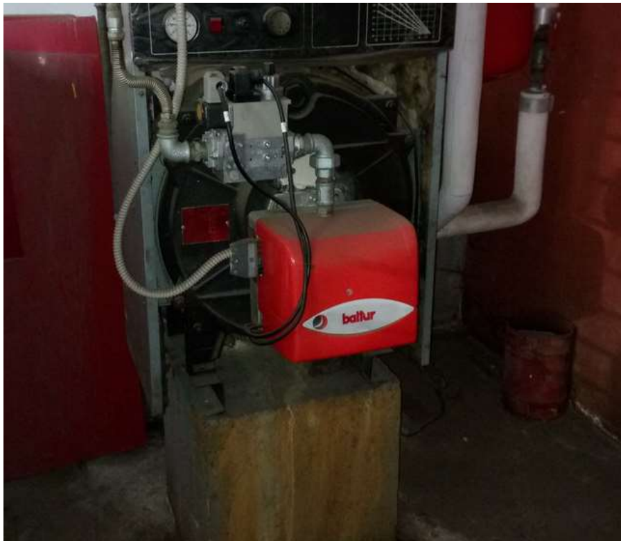
Fig.3.3.6 Bruciatore da 35 kW
