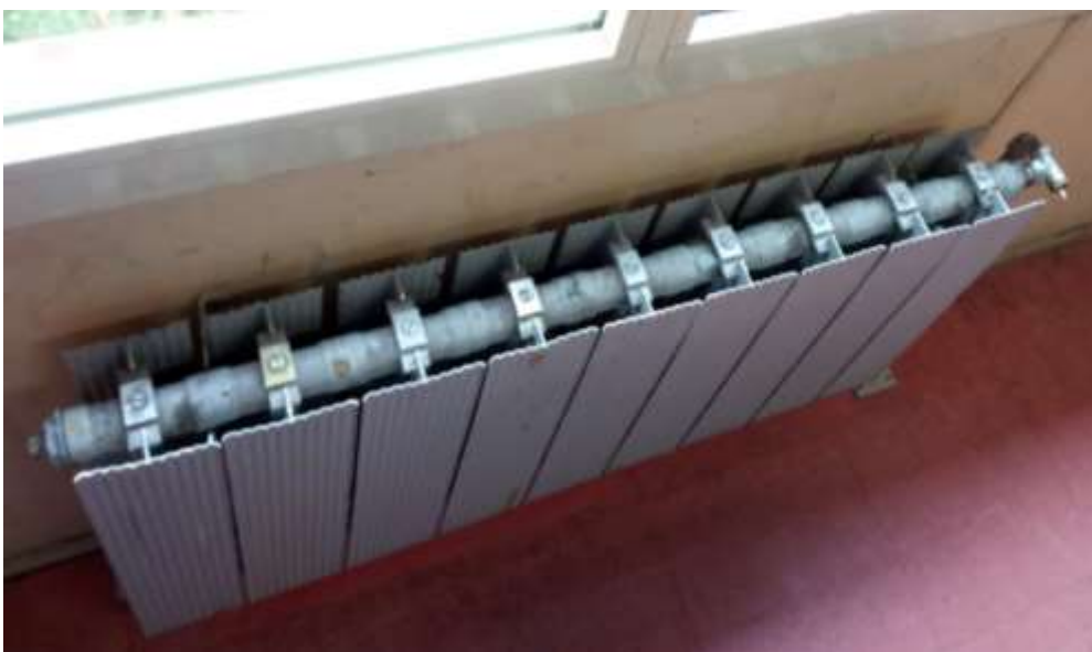
Fig.5.3.7 – Termosifoni senza valvole termostate
