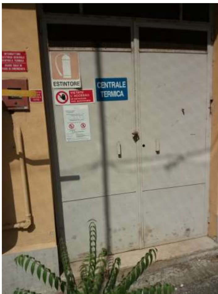
Fig.9.3.1 – Centrale termica, inaccessibile per il mancato possesso di chiavi
