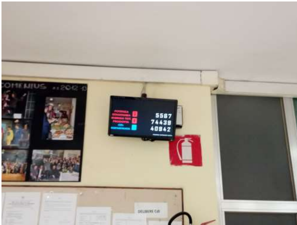
Fig.9.3.6 – Monitor dell'andamento dell'impianto fotovoltaico
