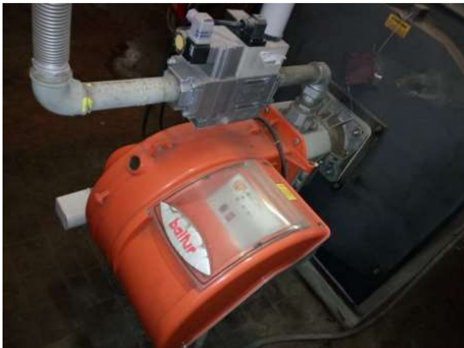
Fig.3.3.2 - Bruciatore da 550 kW
