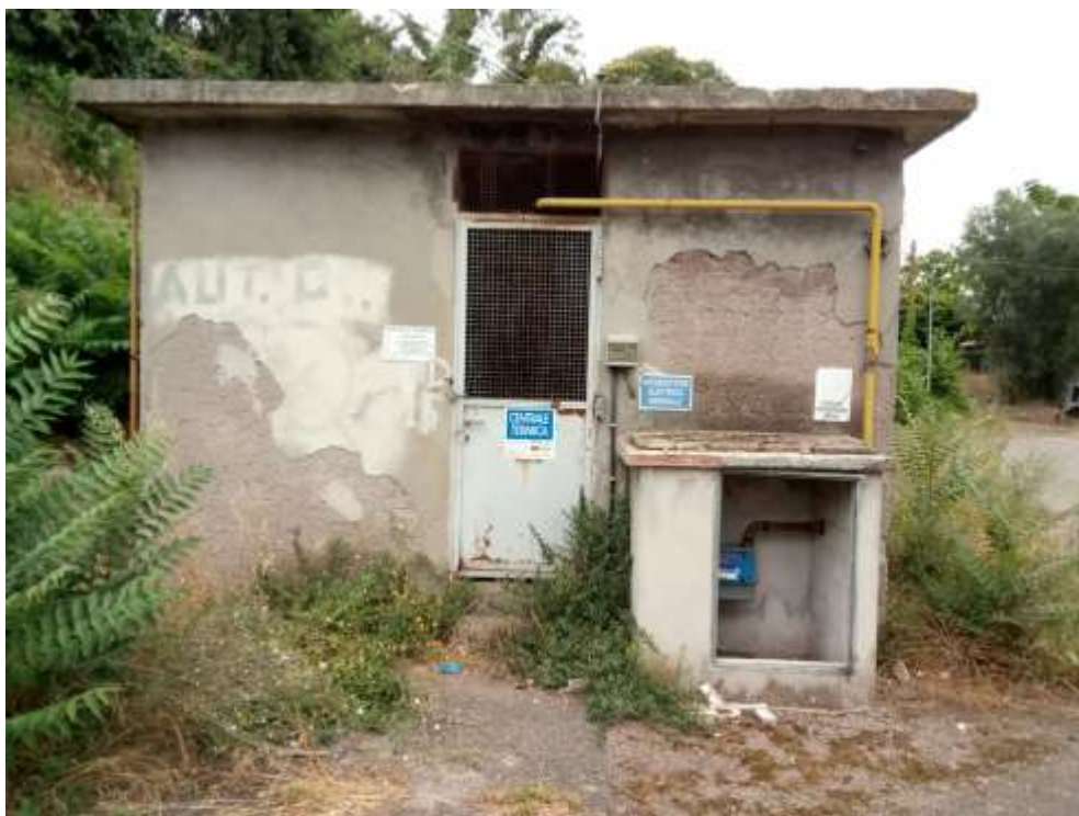
Fig.5.3.1 – Centrale non accessibile
