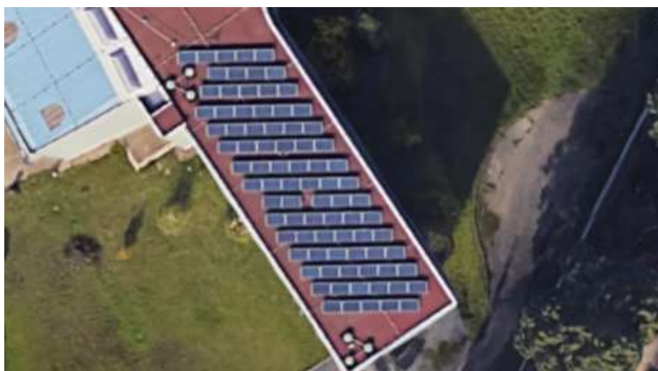
Fig.10.3.5 – Immagine satellitare dei pannelli fotovoltaici
