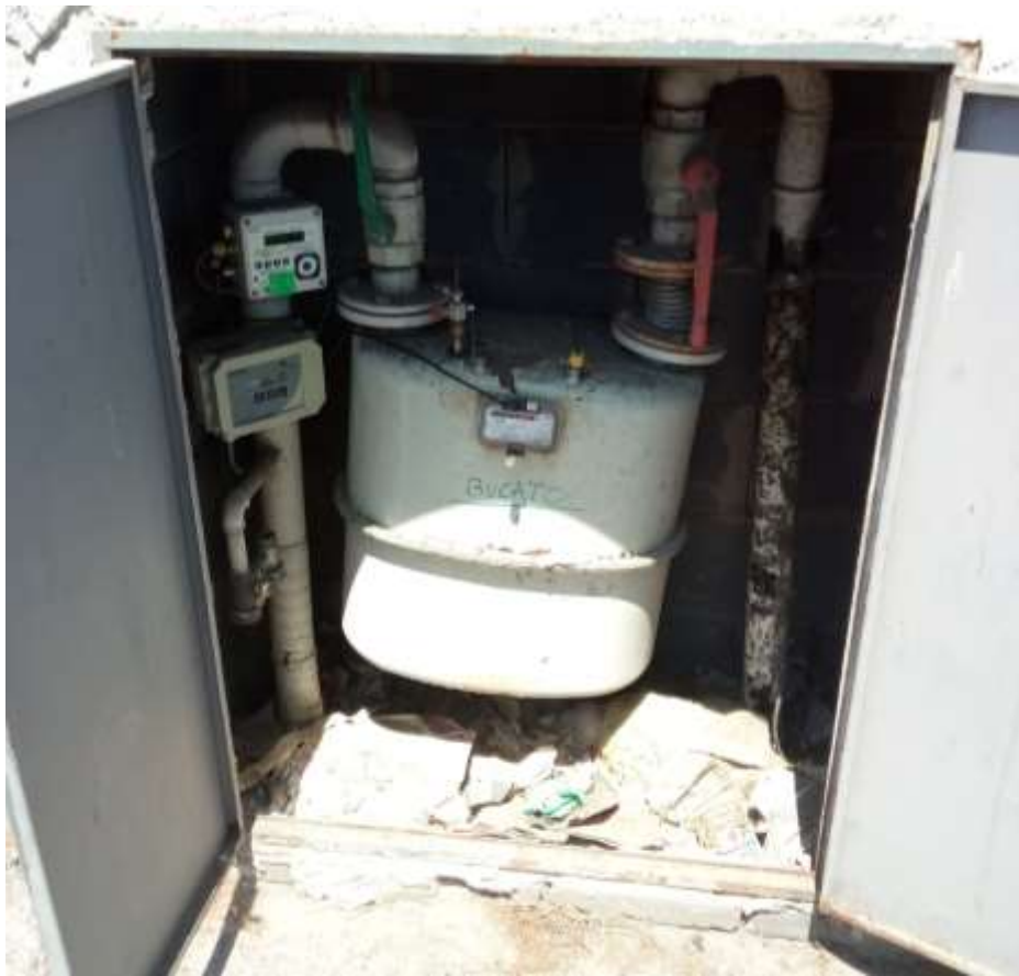
Fig.10.3.2 – Contatore del GAS
