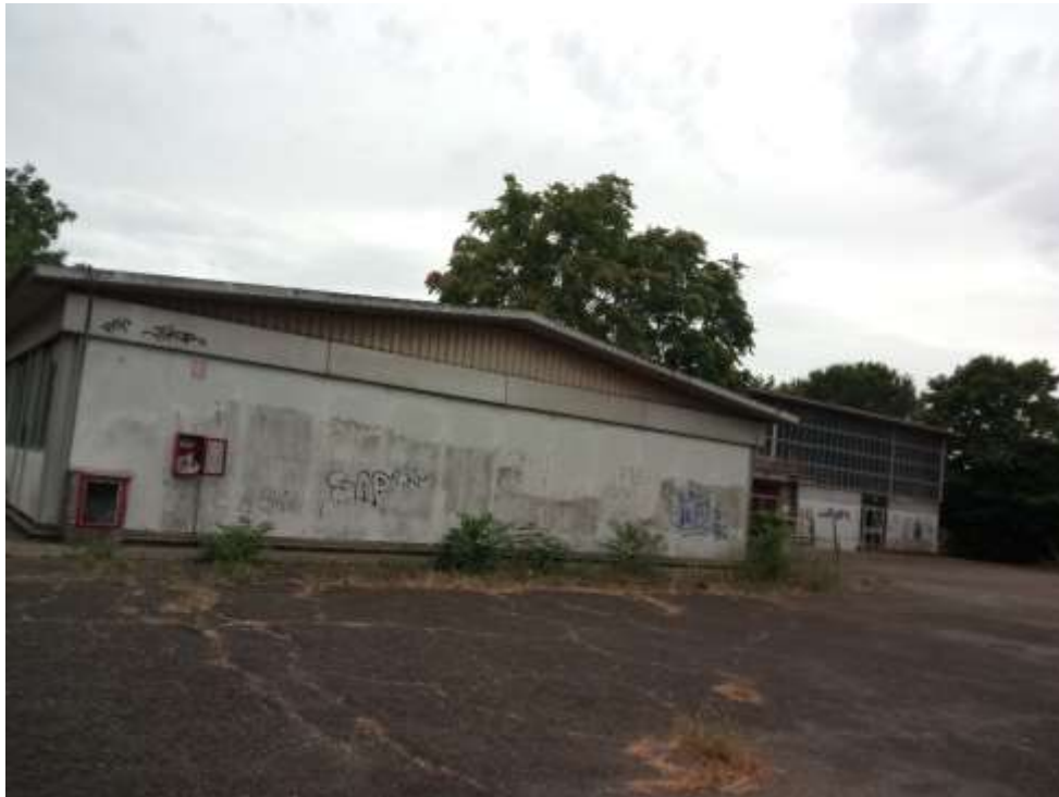
Fig.5.2.11 – Tetto a doppia falda spiovente
