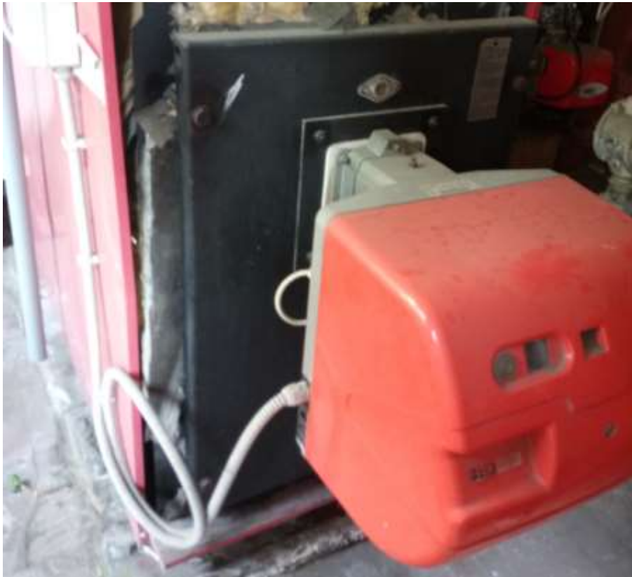
Fig.3.3.5 - Bruciatore da 325 kW
