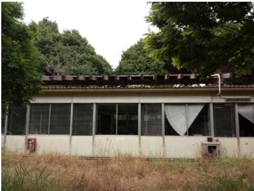
Fig.5.3.13 – Foto del tetto con i pannelli installati
