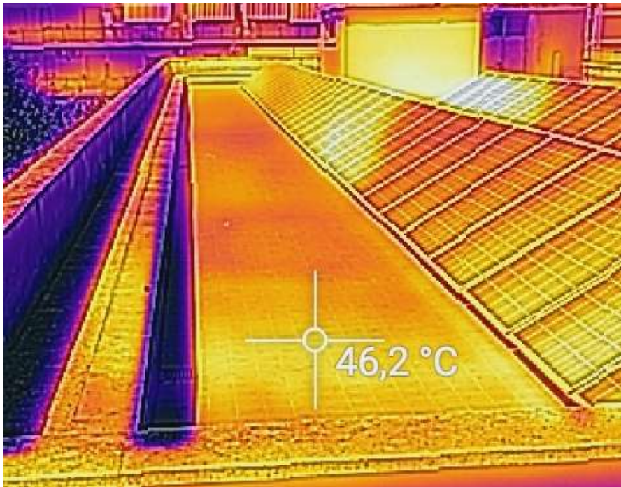
Fig.9.2.9 – Foto con la termocamera del tetto piastrellato in rosso
