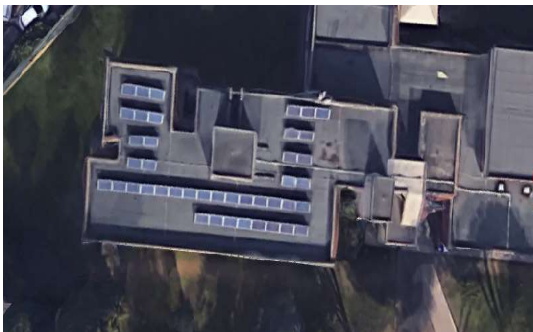
Fig.12.3.1 – Immagine satellitare dell'impianto fotovoltaico
