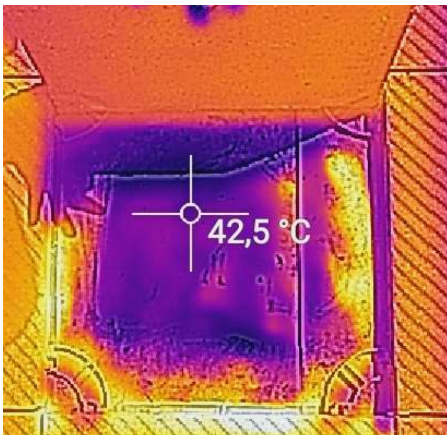
Fig.9.2.11 - Foto con la termocamera della superficie al di sotto della della copertura ventilata
