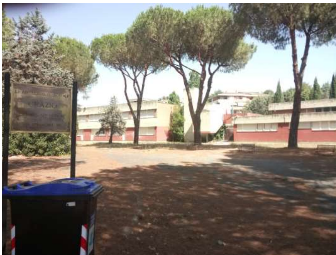
Fig.12.1.1 – Ingresso principale, liceo Orazio sede in via Spegazzini
