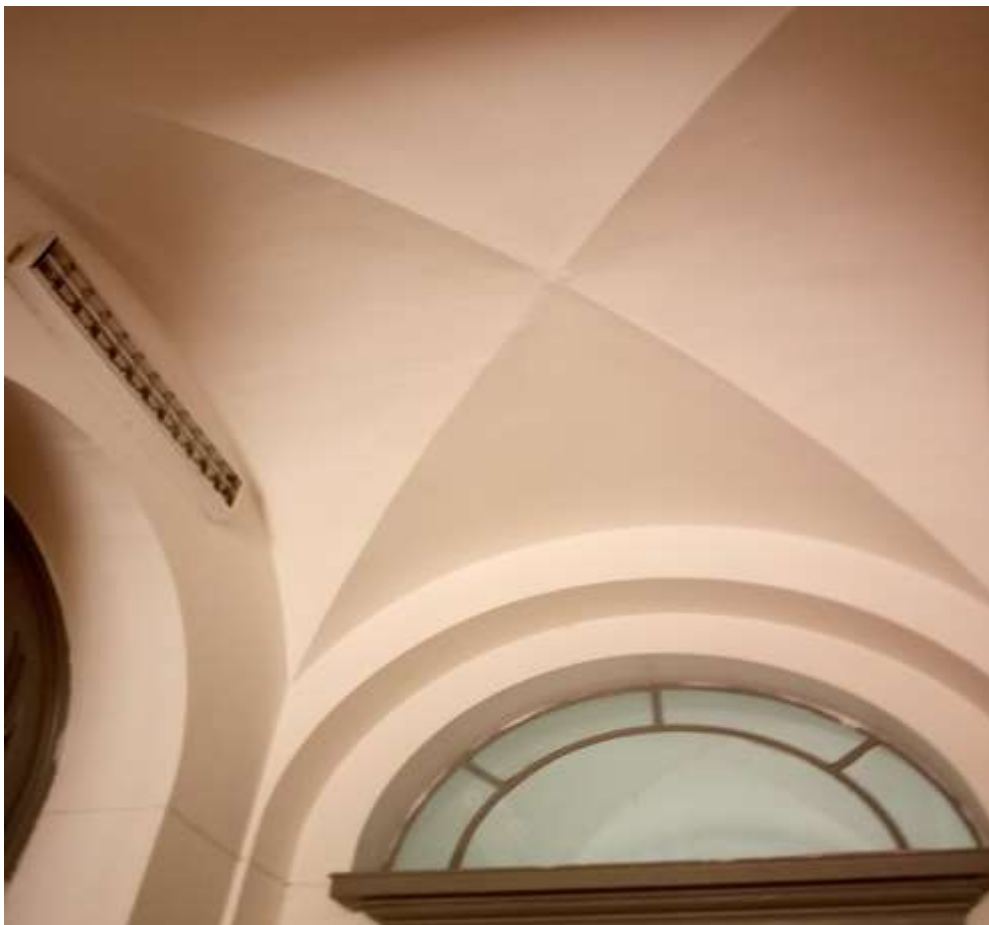
Fig.3.2.1 – Pareti e soffitto dell'edificio principale
