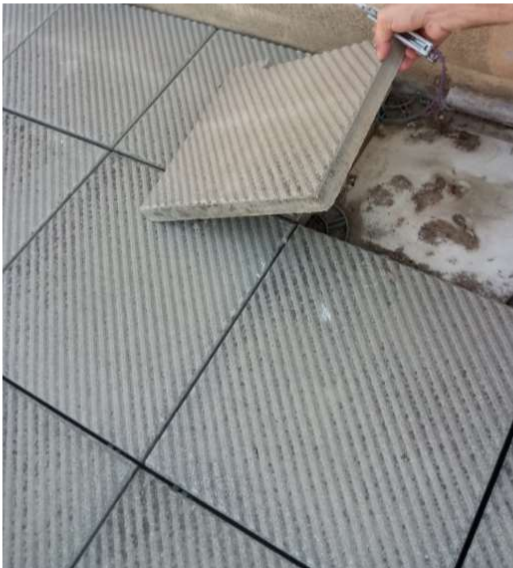
Fig.9.2.8 – Copertura ventilata poggiata su plastica
