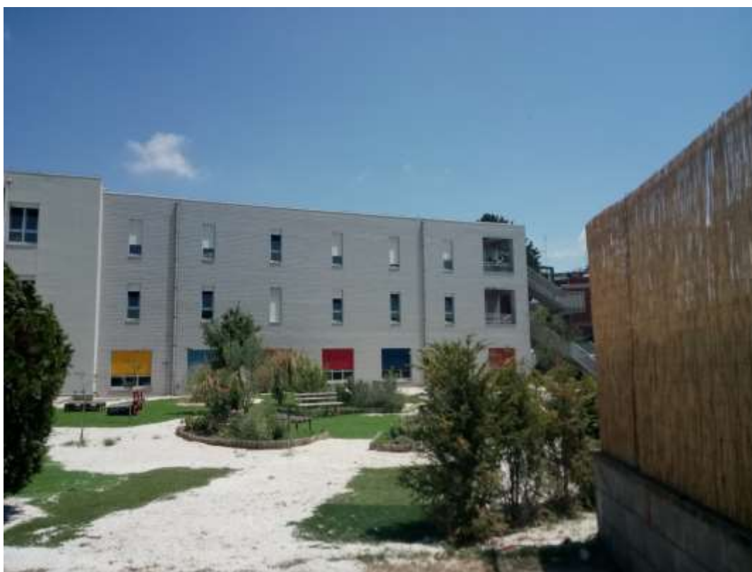
Fig.10.1.2 – Facciata laterale del liceo Keplero
