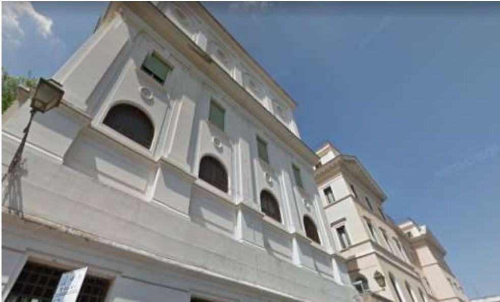
Fig.3.1.2 – Facciata esterna della palazzina B
