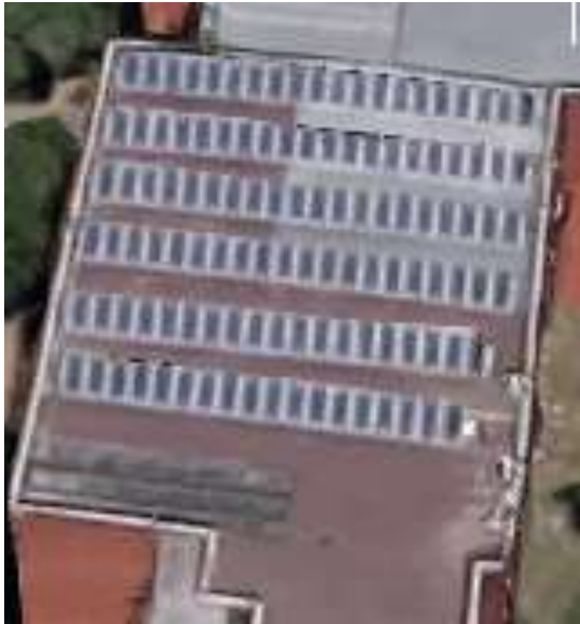
Fig.4.3.5 – Immagine satellitare dei pannelli solari
