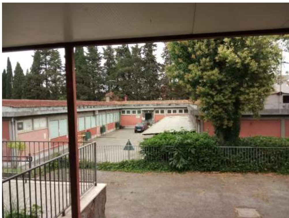
Fig.5.1.3 – Prefabbricati di colore rosso
