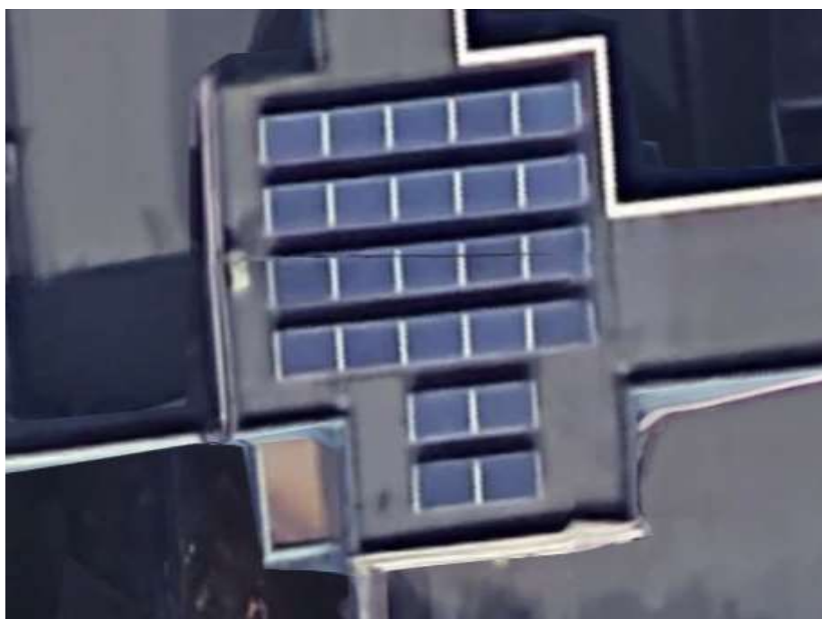
Fig.13.3.2 – Immagine satellitare dell'impianto fotovoltaico
