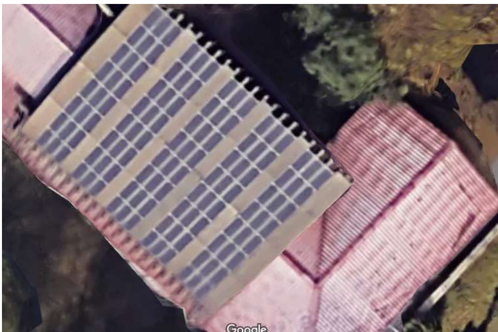
Fig.5.3.12 – Immagine satellitare del tetto con i pannelli installati
