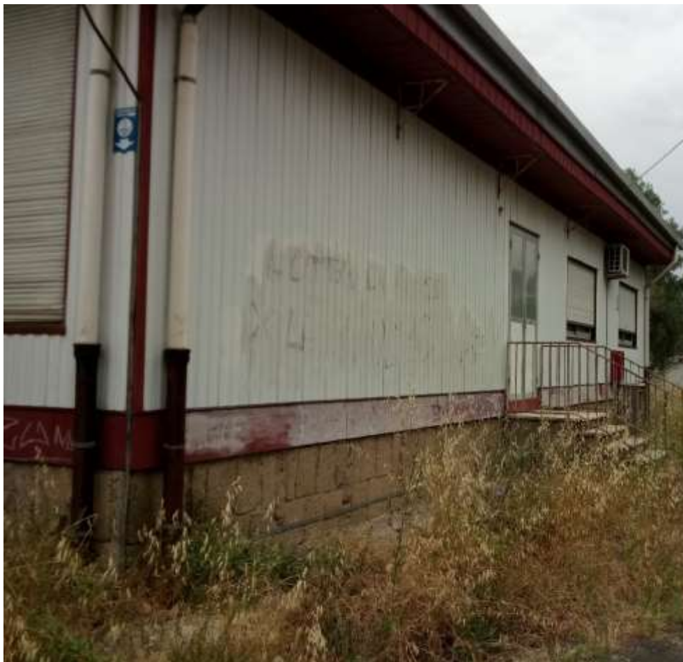
Fig.5.2.1 – Parete esterna edificio
