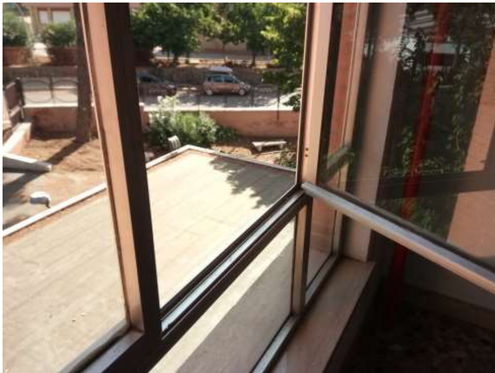
Fig.11.2.3 – Infissi in alluminio con vetro singolo
