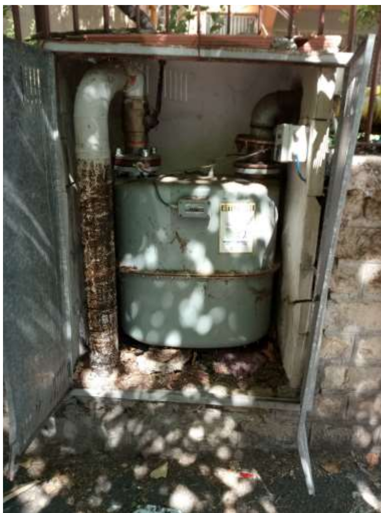
Fig.7.3.6 – Contatore del GAS
