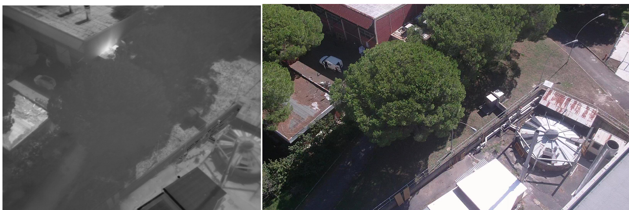
Figura 24. Termografia e immagine video della manutenzione della centrale termica
