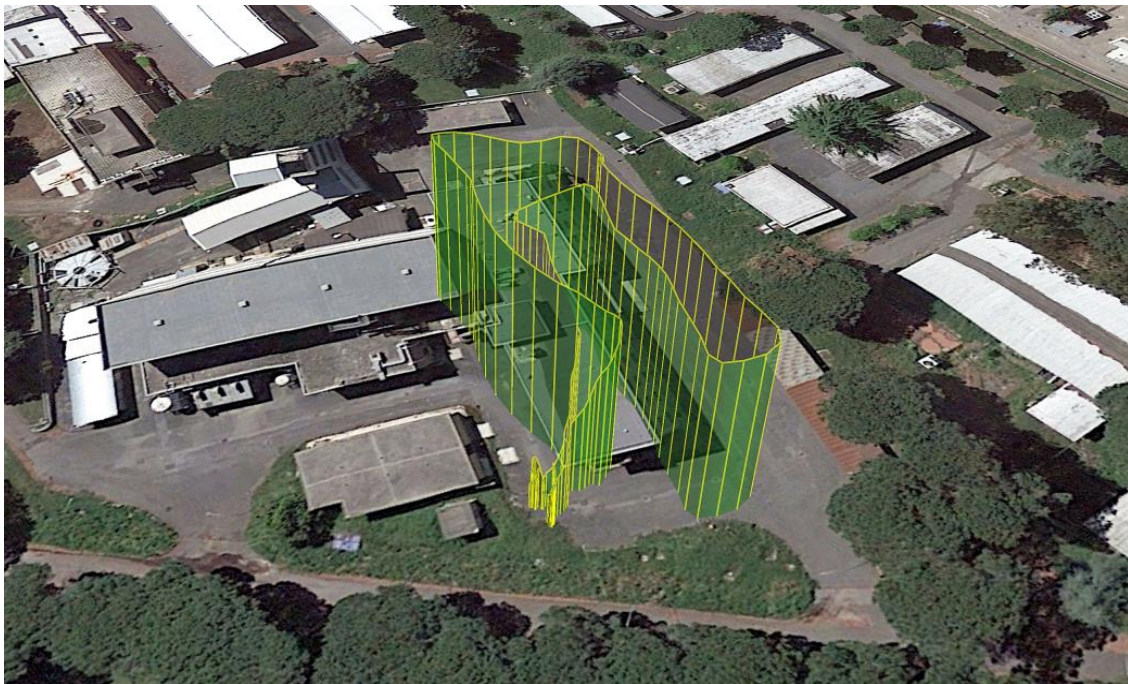
Figura 11. Traiettoria spaziale del drone sull'edificio F40 nello Smart Village ENEA
