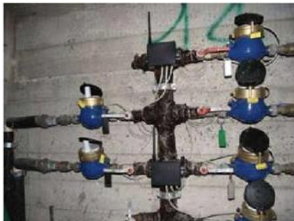
Figura 12. Esempio di centralina di raccolta e collegamento a più contatori.
