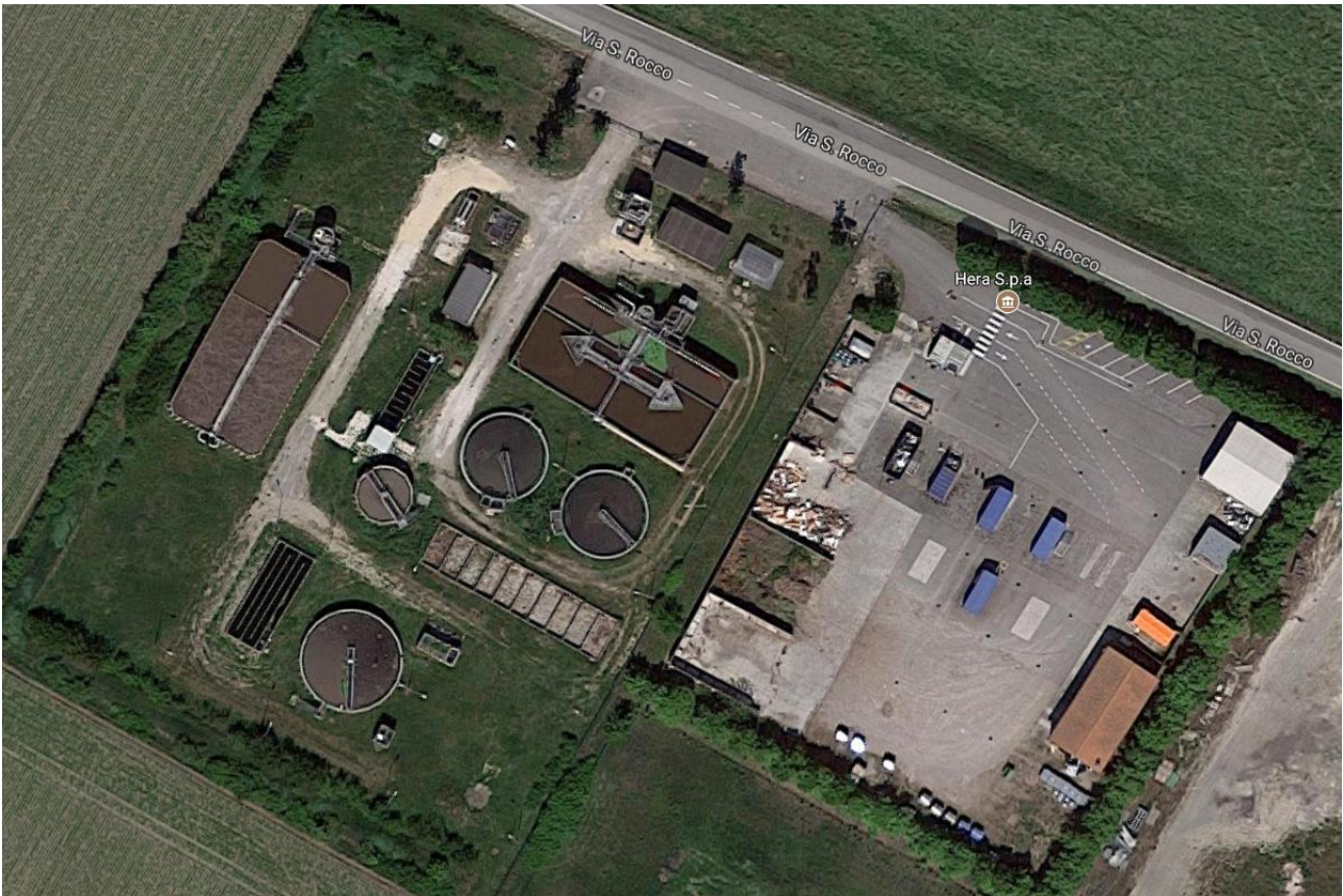
Figura 19. Impianto di trattamento delle acque reflue civili
