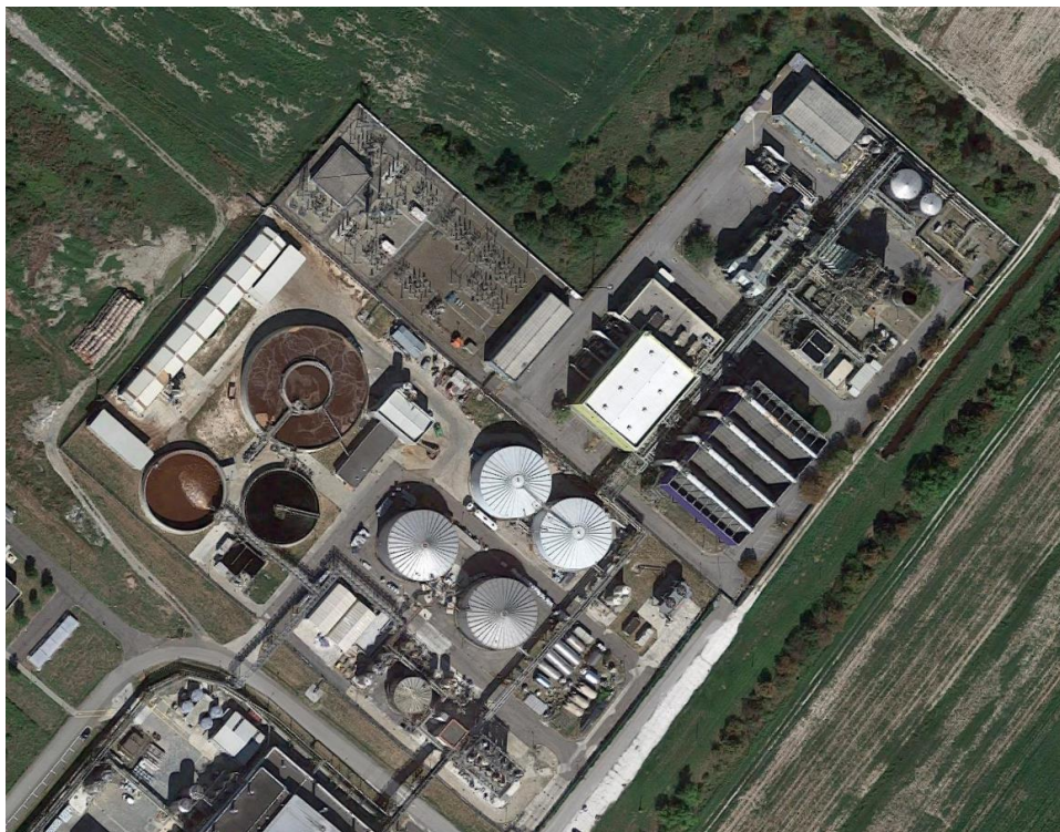
Figura 1. Vista d'insieme dello stabilimento industriale
