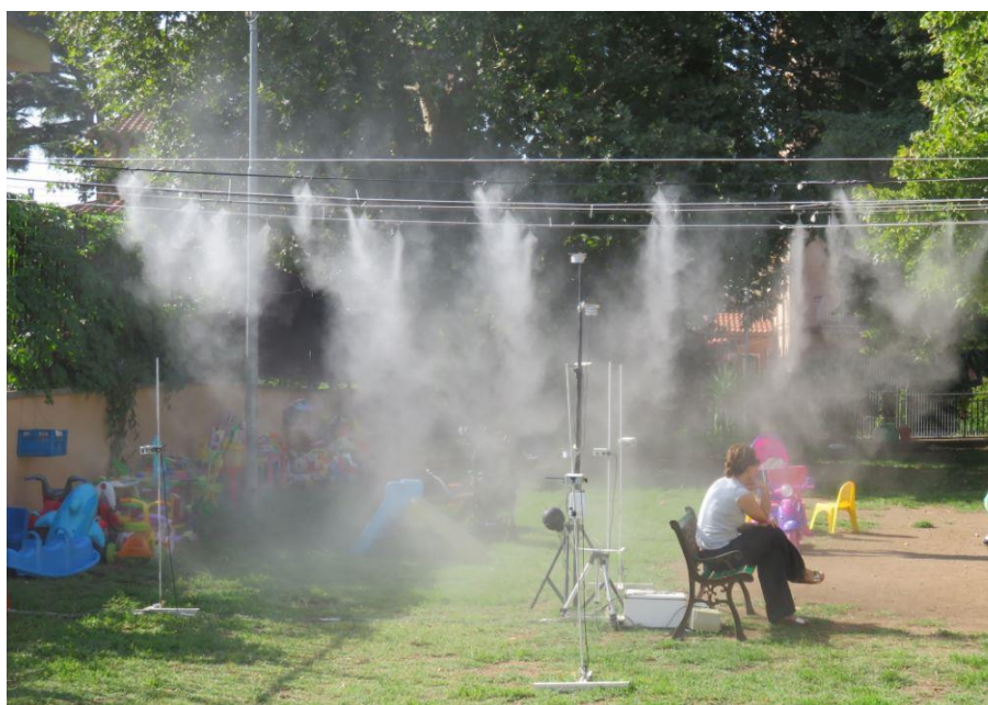
Figura 69: Vista del sistema di nebulizzazione e attrezzatura in campo del monitoraggio ENEA
