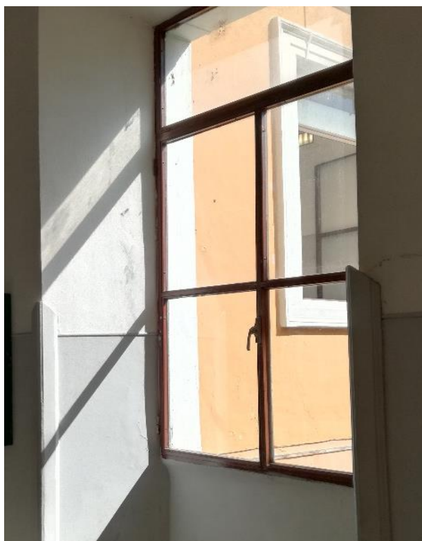
Fig. 3.2.2 – Infisso in ferro con vetro singolo
