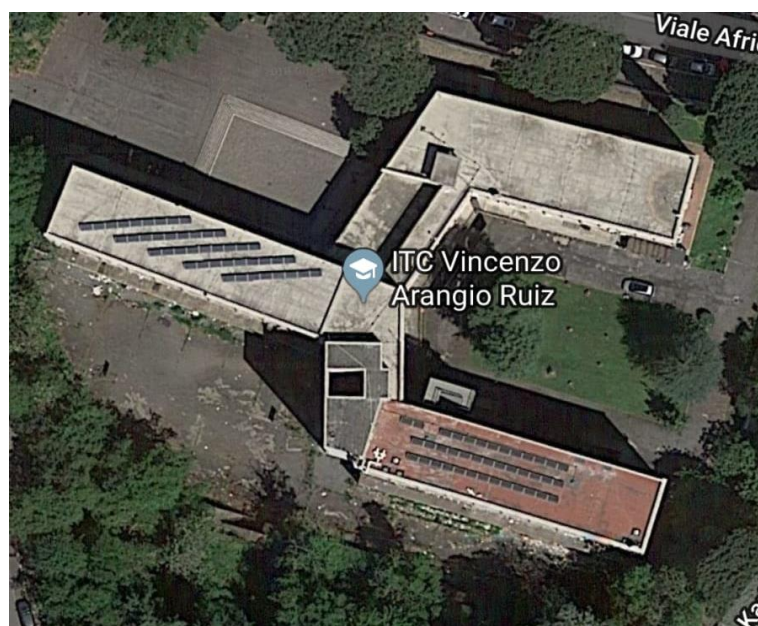
Fig.3.10.2 - Impianto fotovoltaico visto da satellite.
