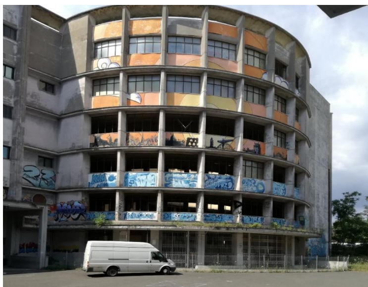
Fig.3.4.3 - Parte dell'edificio in stato di abbandono, circa un quarto delle aule non è utilizzato
