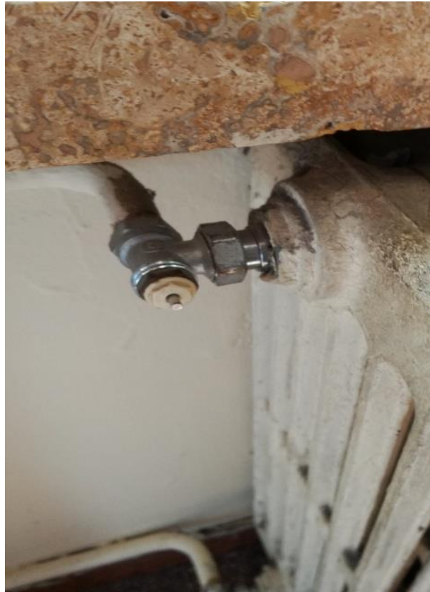
Fig.3.6.3 - Termosifone senza manopola termostata
