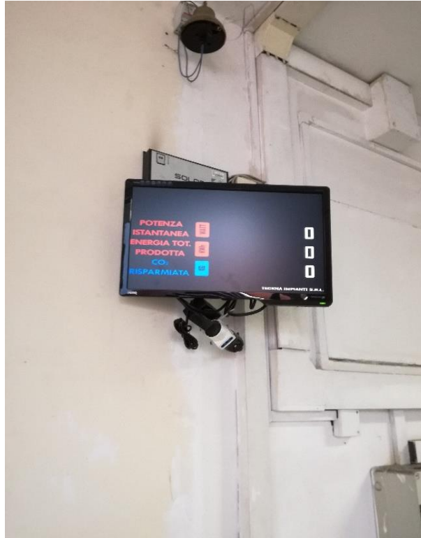
Fig.3.7.2 - Display per il monitoraggio non funzionante
