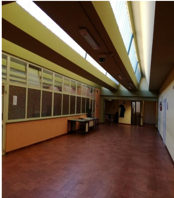
Fig.3.3. 1 - Copertura con travi a vista in cemento armato e lucernai
