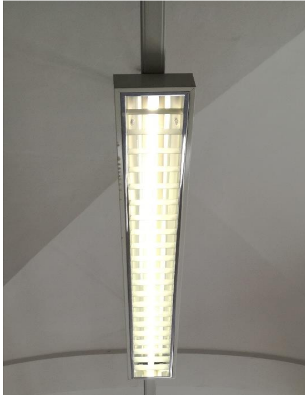
Fig. 3.2.4 - Lampade fluorescenti di vecchia generazione
