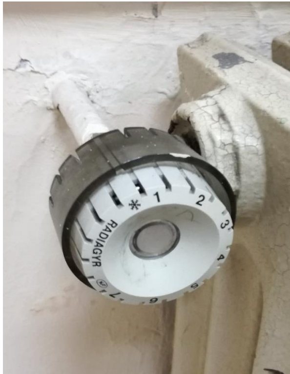
Fig. 3.1.4 - Manopola termostata datata e bloccata
