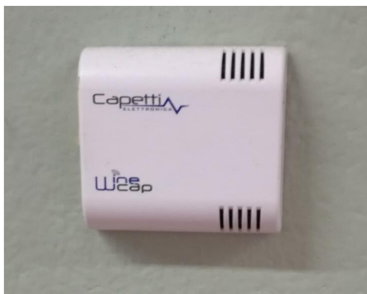
Fig.3.4.4 - Sensore di misura della temperatura posizionato in un corridoio
