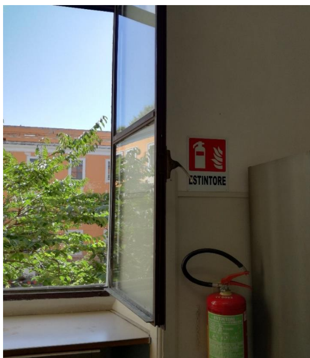
Fig. 3.2.3 – Infisso in ferro con vetro singolo
