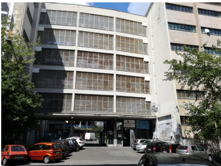
Fig.3.4.2 - Entrata secondaria I.T.C Di Vittorio- I.T.I Lattanzio e, a destra, il corpo nuovo con le altre aule
