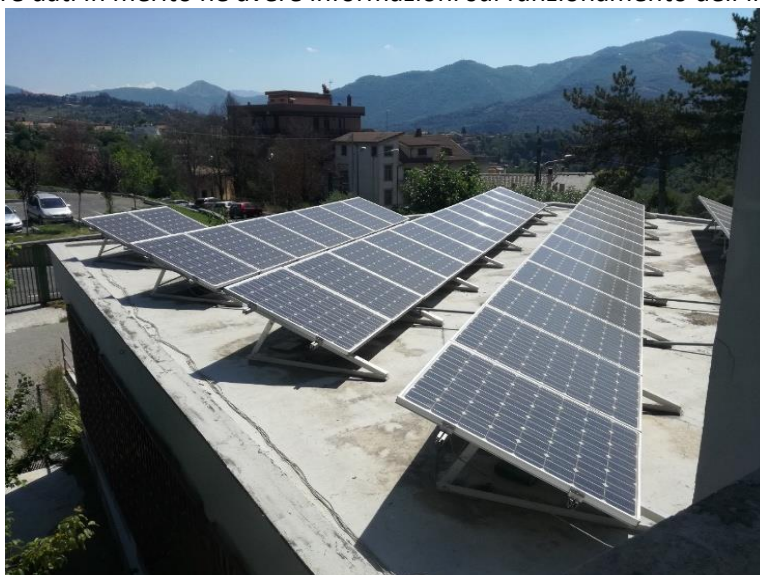
Fig.3.11.3 - Parte dell'impianto fotovoltaico visibile dalle aule mai entrato in servizio
