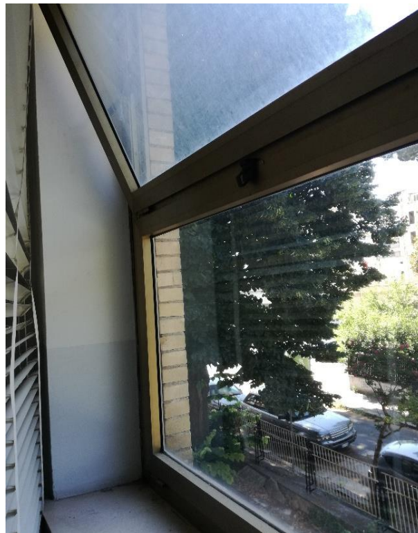
Fig.3.8.2 - Finestra in alluminio e vetro singolo
