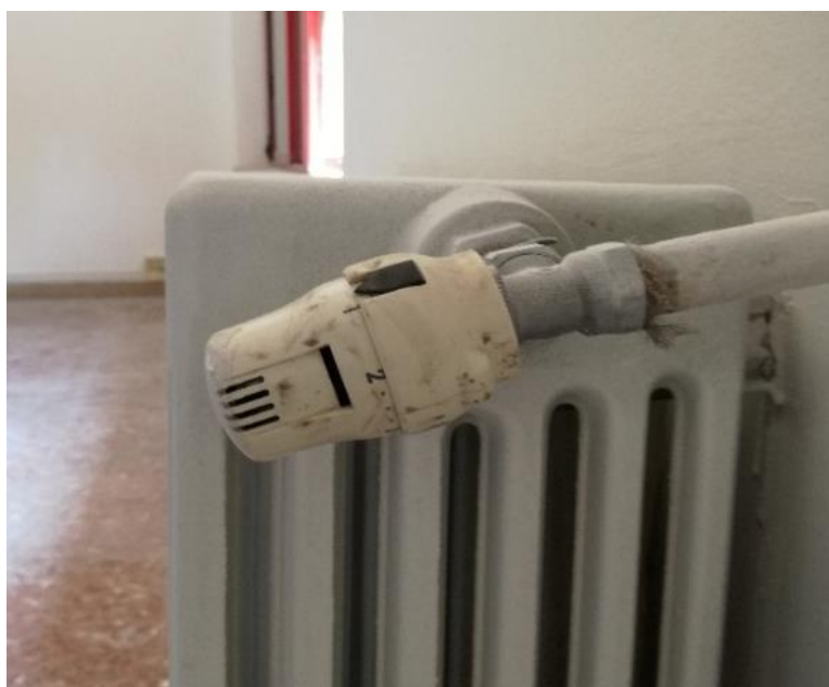
Fig.3.7.3 - Manopola termostata vandalizzata con asse piegato e meccanismo bloccato
