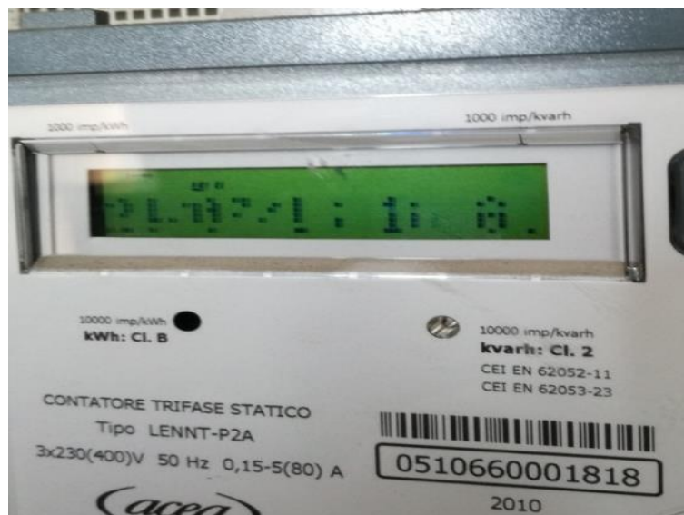
Fig.3.6.5 - Display contatore rotto e non leggibile
