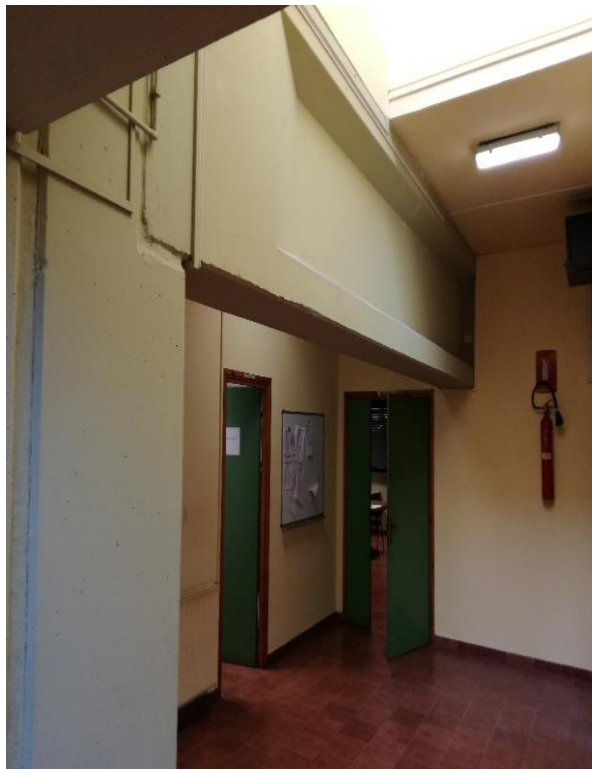
Fig.3.3.2 - Travi in cemento armato prefabbricate a vista e non coibentate
